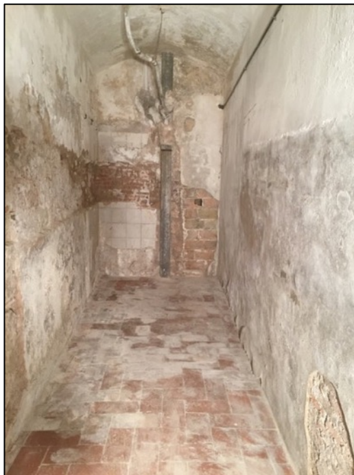
Fotografia 152. Sala on s'ha realitzat el repicat parietal cala AA1.
