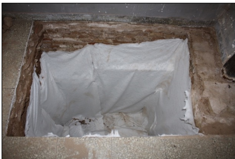
Fotografia 102. Cobriment de la cala K11 amb geotèxtil.
