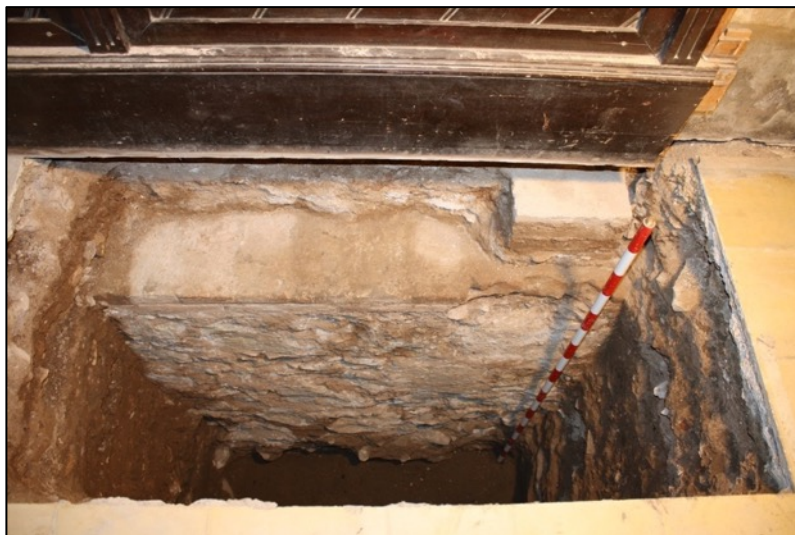
Fotografia 35. Fonamentació mur UE179.
