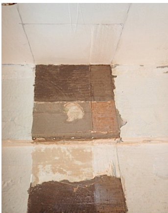
Sostre: modificat amb planxes de guix i colors dels recobriments de les bigues de ferro.
