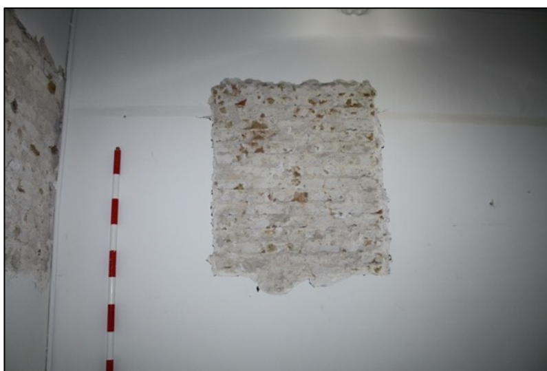
Fotografia 268. Mur de maons UE2011 ja documentat a la planta baixa. Construït per sobre de la línia d'arrasament de la muralla a mitjans del segle XIX.
