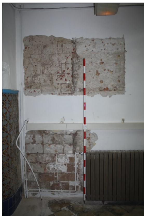
Fotografia 284. Vista del mur de maons de mitjans del segle XIX UE1027 juntament amb ampliació feta de maons aplacats associat a la fase del Borsí, UE1034.
