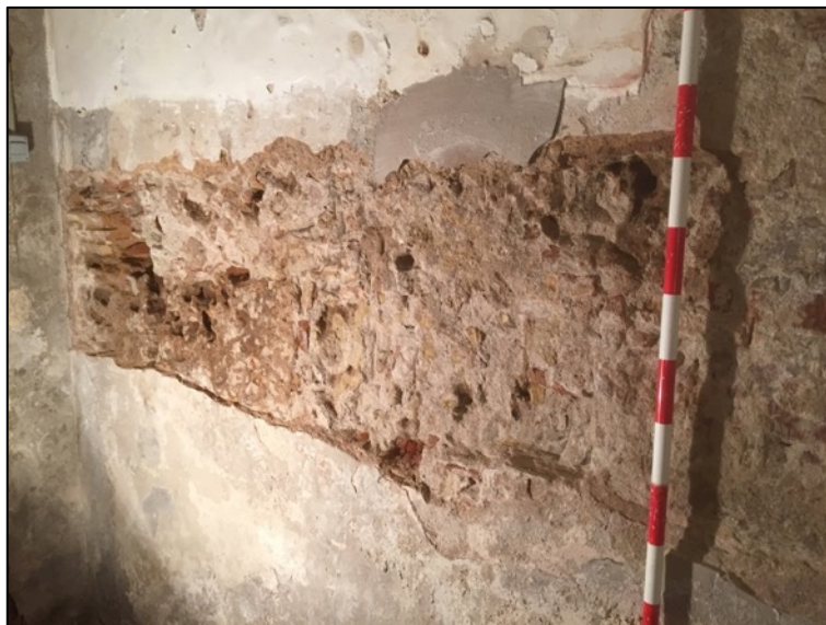
Fotografia 156. Vista del frontis torre 49, UE1000, amb reparació del mur al s. XIX amb pedres i murter de calç.
