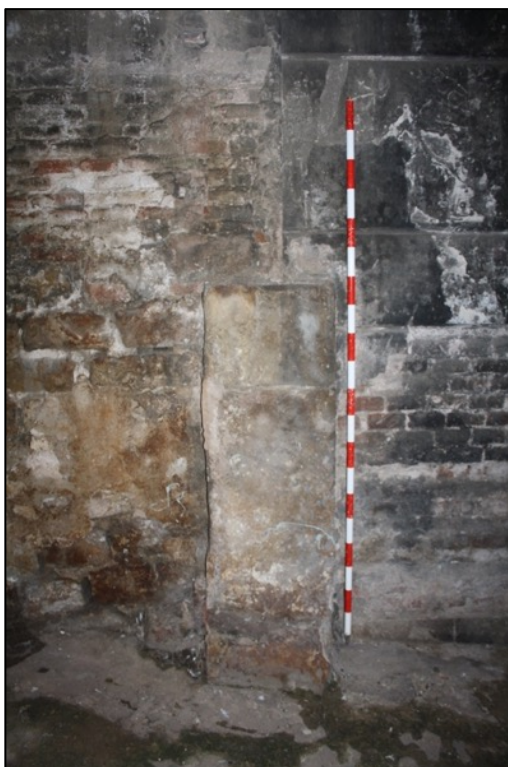
Fotografia 142. Detall carreus treballats de la muralla romana reaprofitats.
