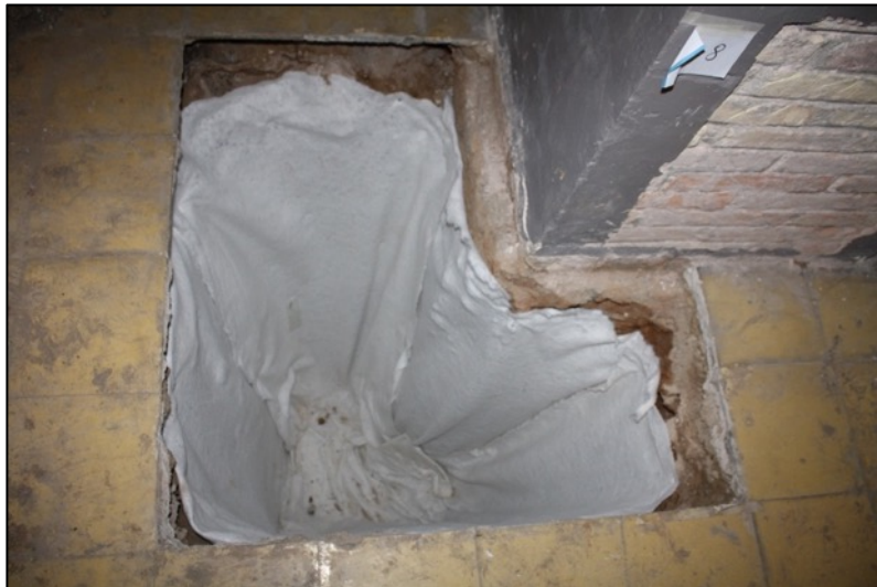
Fotografia 63. Cobriment de la cala K8 amb geotèxtil.
