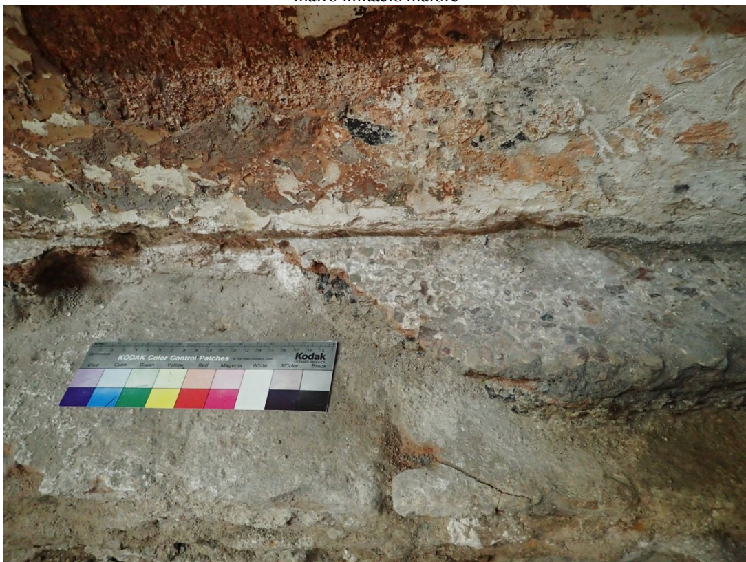
Resta de paviment original de la sala. "Terratzo" amb formigó de calç i triturats de marbre.
