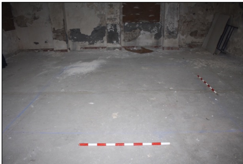
Fotografia 116. Llosa de formigó UE100.
