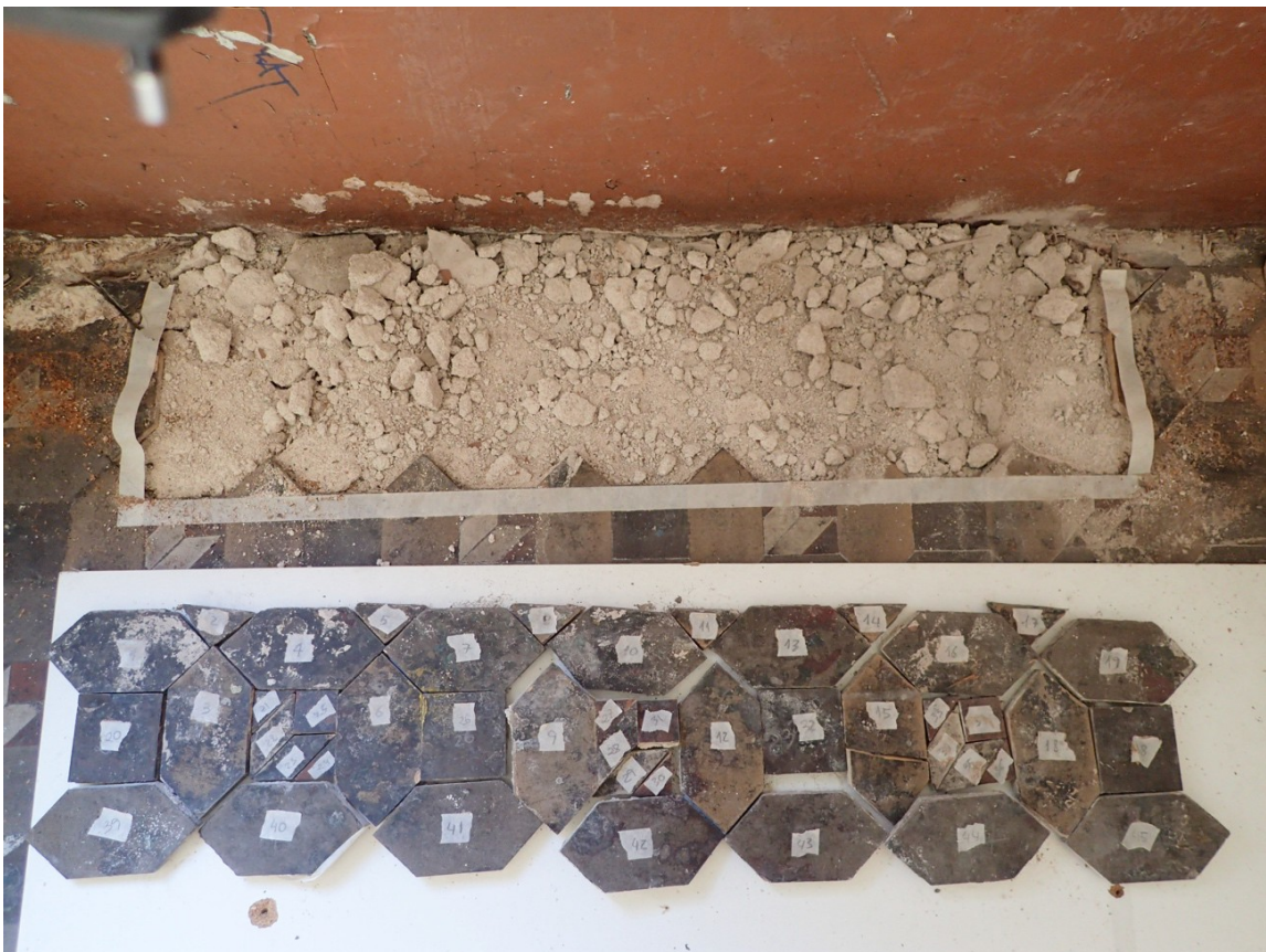
Extracció de mosaic Nolla per facilitar les cales estructurals.
