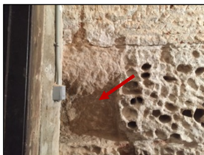
Reforma finals s. XV-XVI documentada en la cantonada del frontis amb imatge d'abans i després de l'excavació
