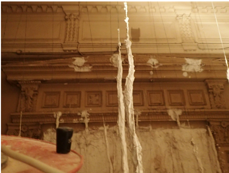
Part superior de la porta de fusta d'accés a la sala principal (Àmbit 15) conservada darrera del sostre actual.
