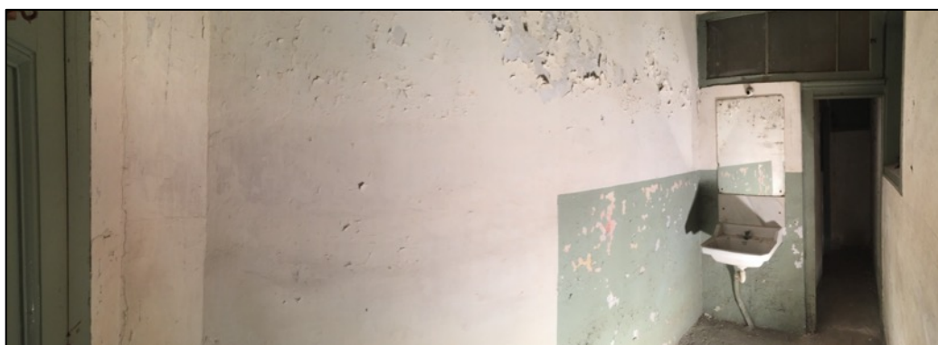
Fotografia 270. Frontis de la torre 49 a la zona de l'entresòl. Actualment el mur es troba cobert per una capa de pintura blanca i en verda, UE1028.
