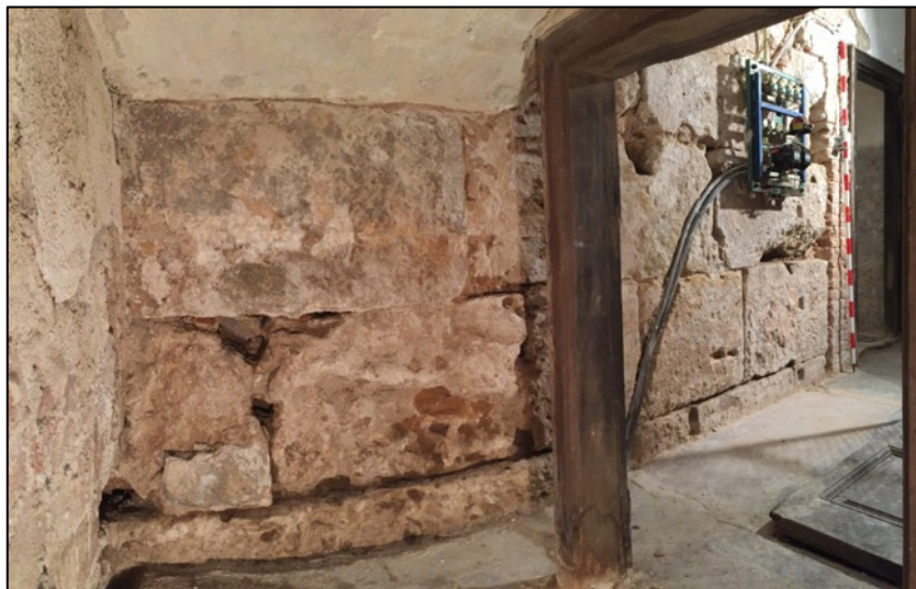
Fotografia 214. Vista general del parament d' opus signinum del lateral occidental de la torre 49.
