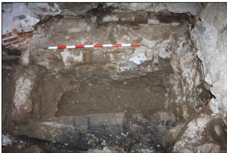
Fotografia 148. Fonamentació façana posterior finca carrer Cervantes 2 UE310.
