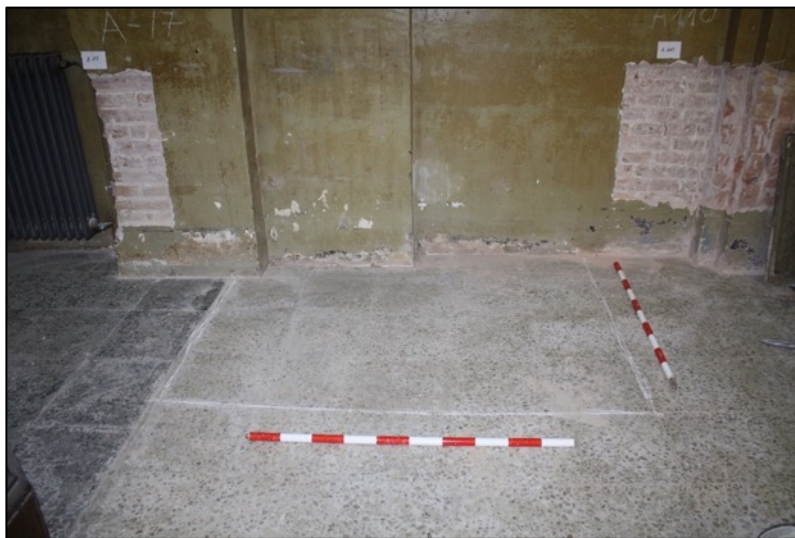
Fotografia 89. Paviment de rajoles de terratzo UE240.
