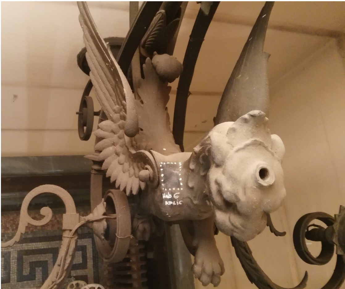
Pàtines de realçament dels aplics metàl·lics.
