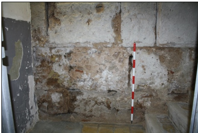
Fotografia 258. Reparacions del panya de muralla romana datades a finals el segle XV-XVI, UE4003.
