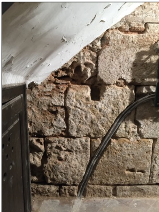
Fotografia 218. Vista general del parament de la torre 49 amb diversos dels orificis que l'afecten.
