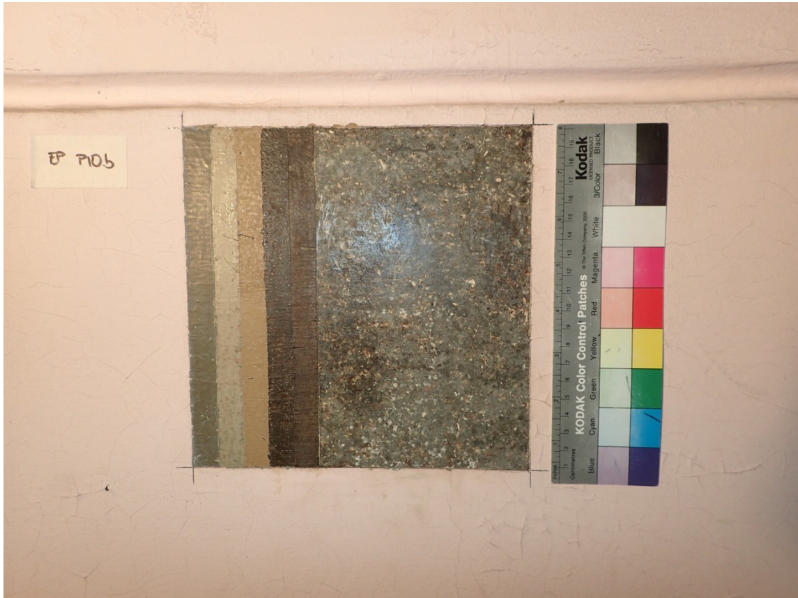
Estucat original d'imitació marbre planxat al foc, damunt totes les fases de pintures esmalts de colors posteriors en que va ser pintat el sòcol de l'escala.
