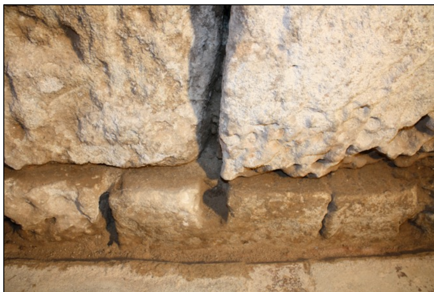
Fotografia 248. Detall encaix de col·locació / transport dels carreus.
