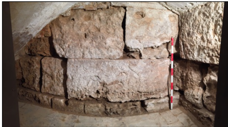
Pany de muralla baiximperial un cop netejada i delimitada en la zona de sota l'escala
