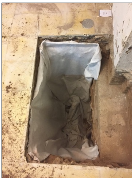
Fotografia 28. Cobriment de la cala K4 amb geotèxtil.
