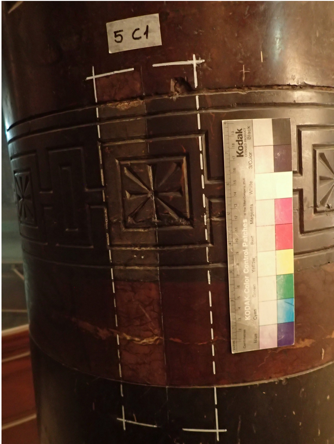
Columnes de marbre massís vermell alacant i emperador fosc (Murcia)
