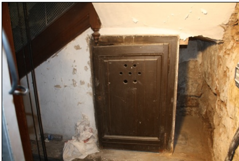
Fotografia 237. Vista sota escala abans intervenció.
