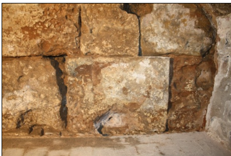
Fotografia 228. Vista de diversos orificis d'època contemporània que afecten el parament de la torre 49.
