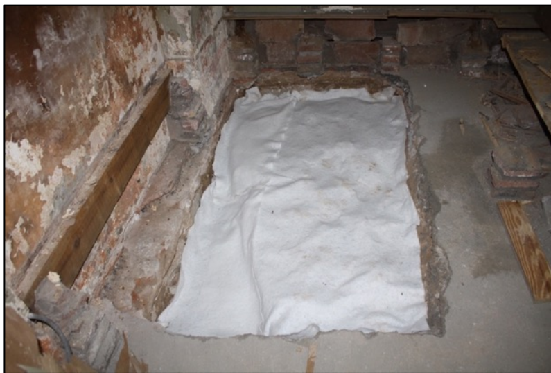
Fotografia 87. Cobriment de la cala K10 amb geotèxtil.
