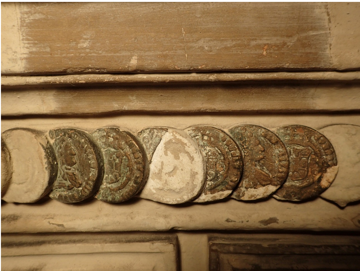
Cala de neteja del fris on es documenten reproduccions de monedes en origen daurades amb or fals.
