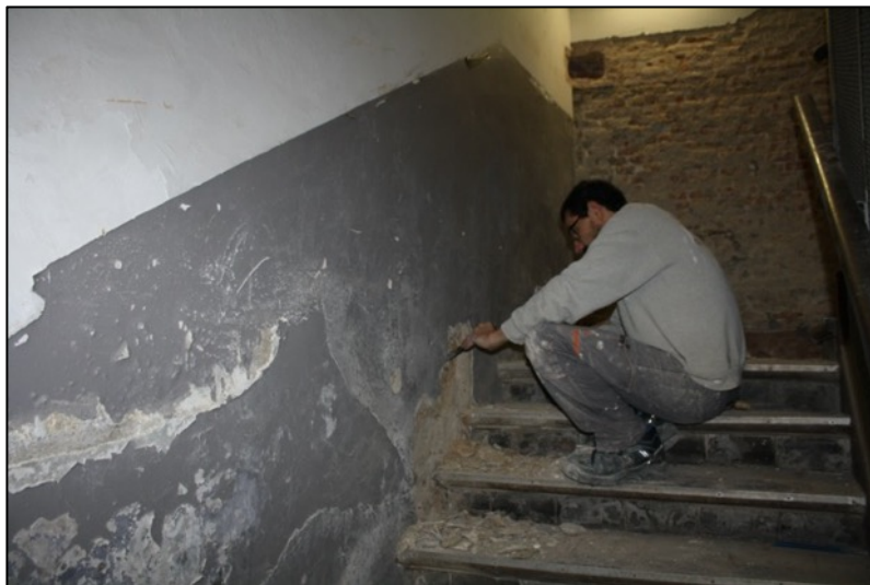
Fotografia 253. Treball d'aixecament de les capes contemporànies.
