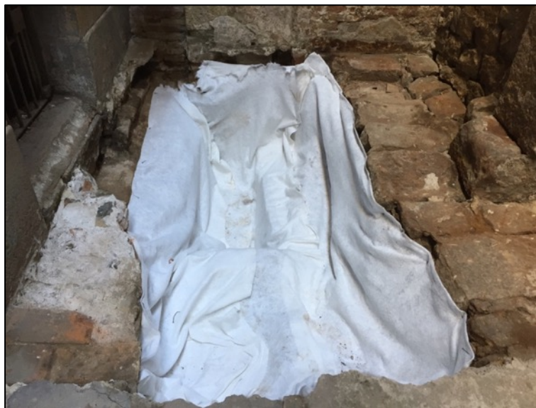
Fotografia 151. Cobriment de la cala KA12 amb geotèxtil.
