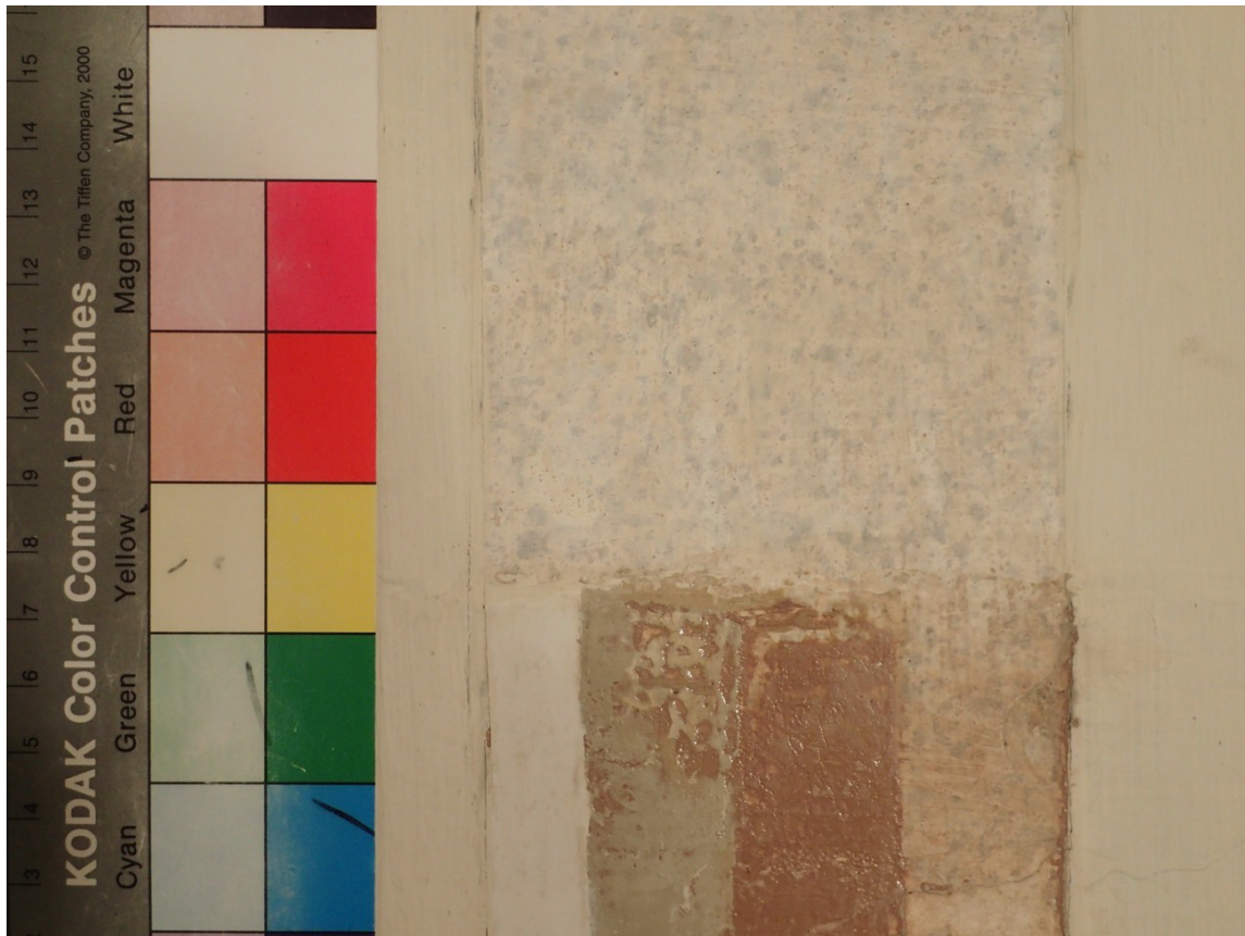
Parets: estuc original de calç amb imitació granit. Damunt diverses pintures esmalt i plàstiques posteriors.
