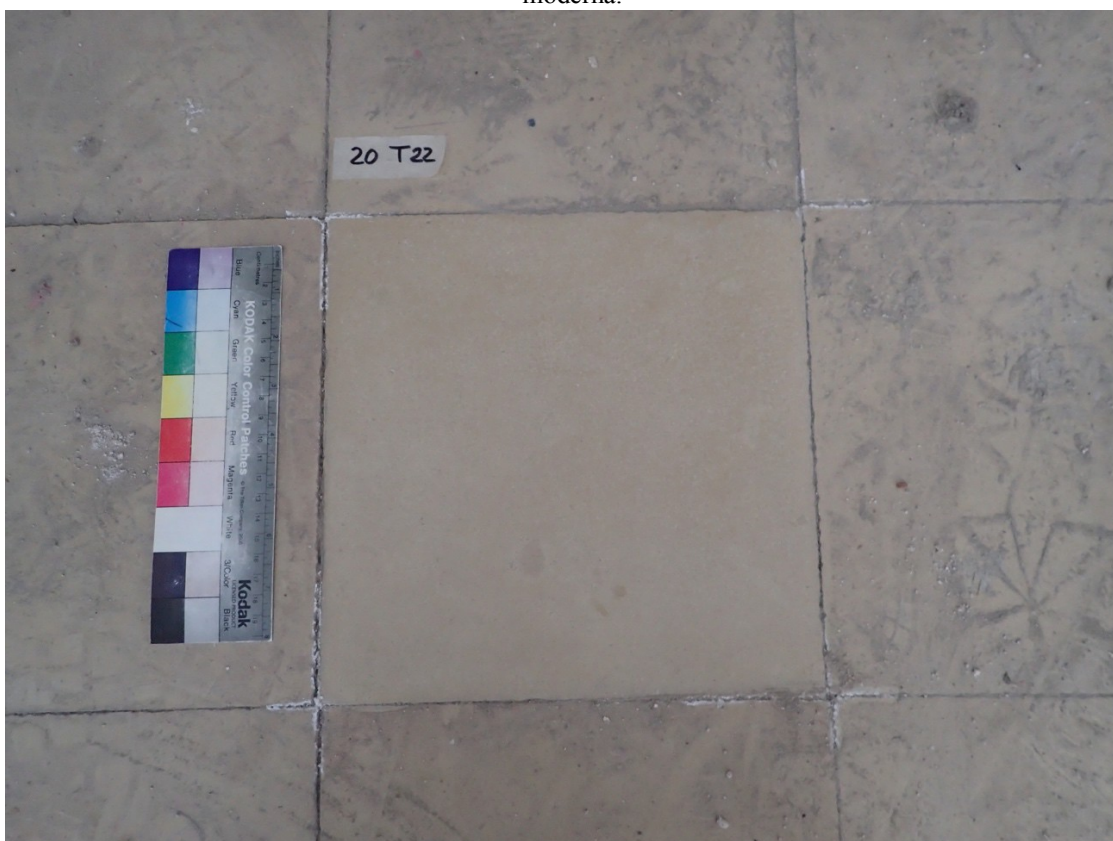
Paviment de rajoles hidràuliques color ocre clar.
