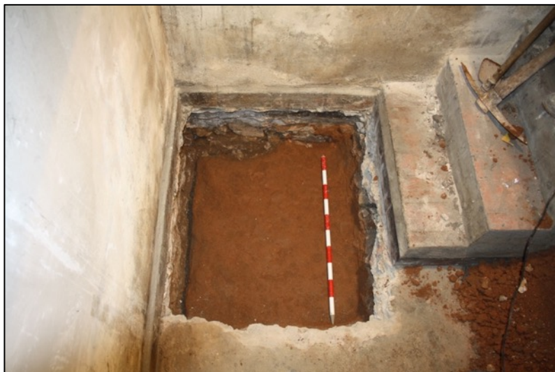
Fotografia 3. Argiles quaternàries UE106 amb rases de fonamentació UE102 i UE104.
