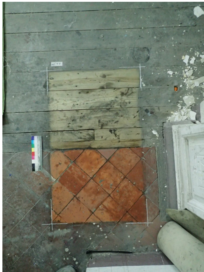
Paviment actual de rajoles ceràmiques i tarima de fusta .
