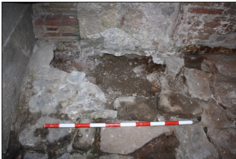
Fotografia 144. Retall que afecta el paviment UE304.
