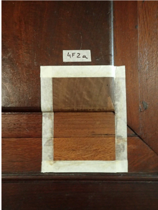
Fusteria de porta de noguera clara i contrafinestra de pi melix envernissat amb gomalaca.
