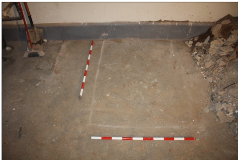
Fotografia 71. Llosa de formigó UE246.
