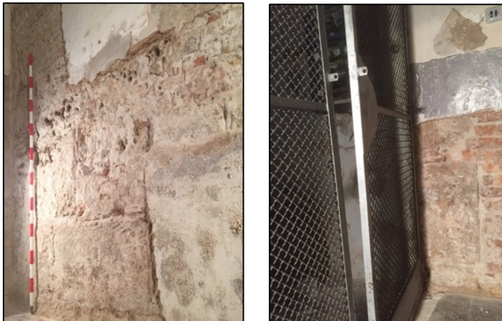
A la dreta vista del frontis de la torre 49 i a l'esquerra un dels carreus de la cantonada occidental de la torre
