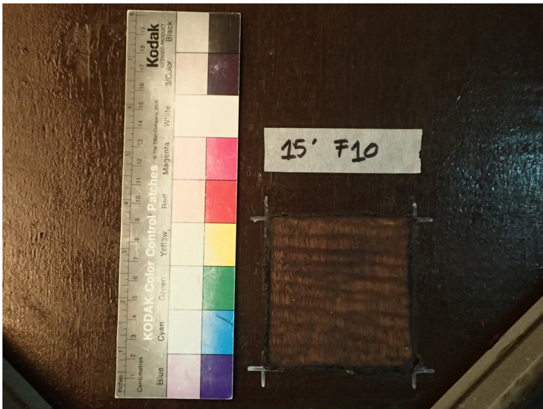
Fusteries de pi amb patines fosques de goma laca per imitar fustes més nobles i fustes nobles xapades.
