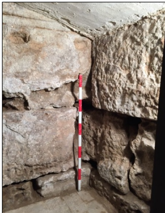
Fotografia 249. Detall encaix de col·locació / transport dels carreus.
