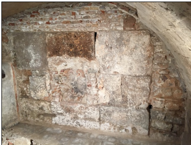
Fotografia 187. Mur de maons UE2011 aixecat per sobre de la cota d'arrasament de la torre 48. Relacionat amb la fase de construcció de la finca veïna a meitat del segle XIX.
