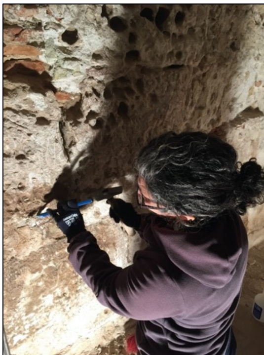
Fotografia 215. Treballs de delimitació torre 49.
