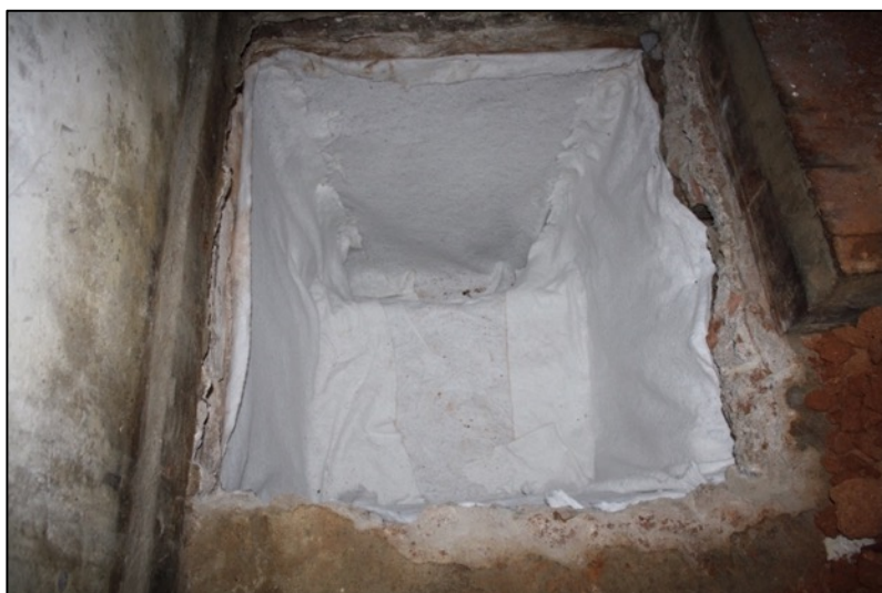
Fotografia 6. Cobriment de la cala K1 amb geotèxtil.
