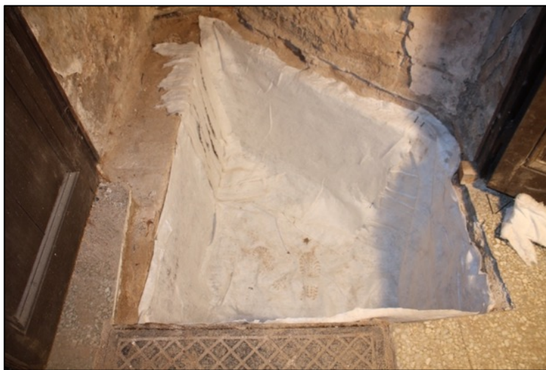
Fotografia 70. Cobriment de la cala K9 amb geotèxtil.
