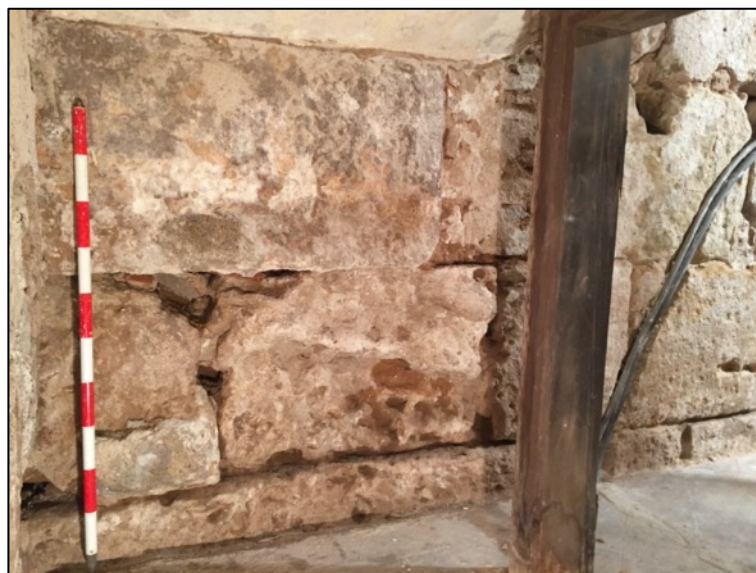
Fotografia 217. Vista lateral occidental torre 49 situada a sota l'escala actual.
