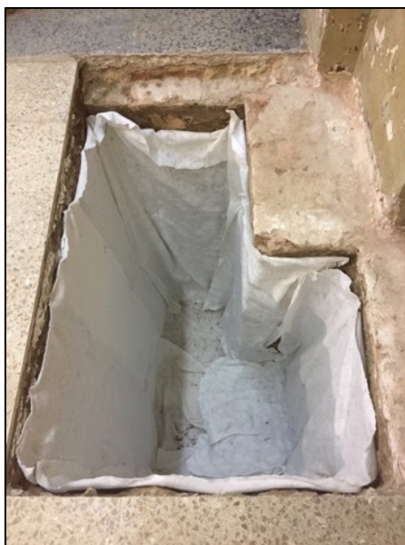
Fotografia 96. Cobriment de la cala K10B amb geotèxtil.
