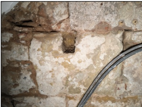
Fotografies 220 i 221. Encaixos en la part baixa del parament. Característics del procés de transport i col·locació de les pedres.
