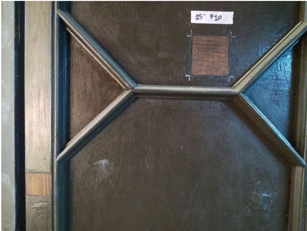
Fusteries de pi amb patines fosques de goma laca per imitar fustes més nobles i fustes nobles xapades.
