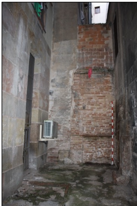
Fotografia 138. Vista sector androna on s'ha obert la KA2.
