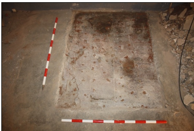
Fotografia 72. Paviment de rajoles de fang UE247.
