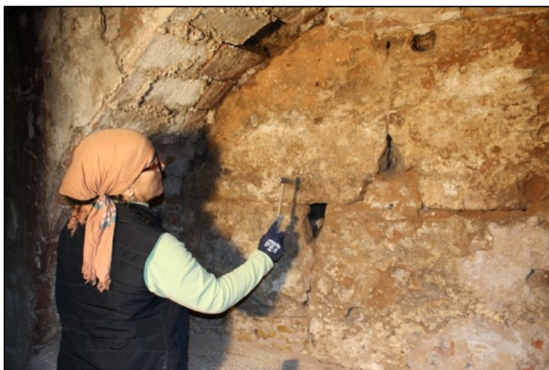
Fotografia 226. Treballs neteja i delimitació dels carreus del parament.
