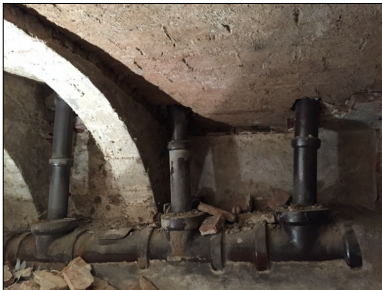
Fotografia 189. Vista de les canalitzacions ceràmiques de l'Antic Borsí localitzades a la zona de la torre 48.
