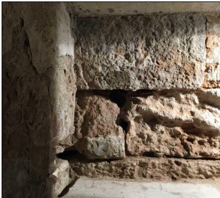
Fotografia 222. Cantonada torre 49 amb pany de muralla. S'observa un dels carreus reutilitzat d'una estructura anterior amb d'altres fortament erosionats.
