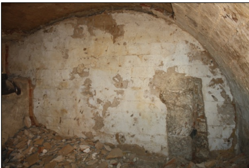
Fotografia 177. Vista general de l'enlluït que cobreix parament torre 48, UE2006.
