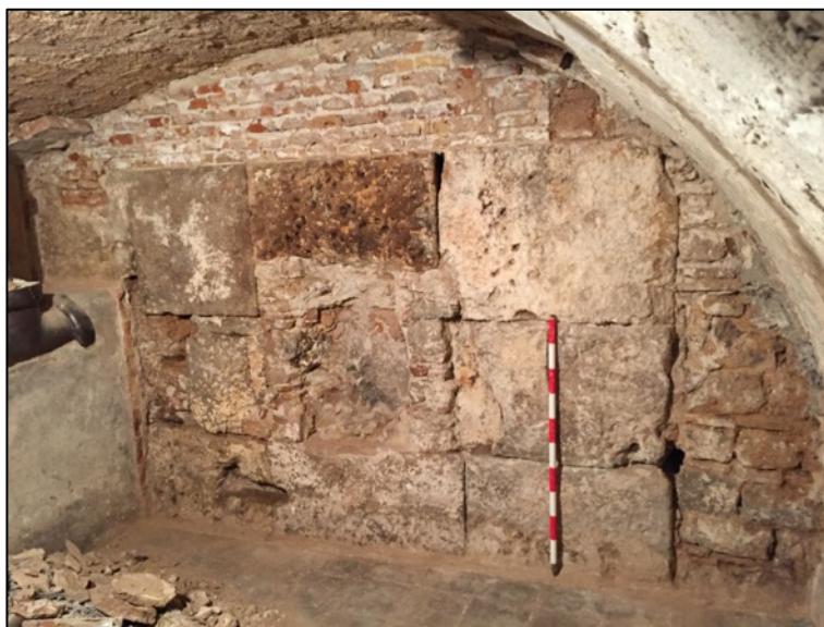
Fotografia 183. Vista del lateral occidental de la torre 48 un cop extretes les restes contemporànies que la cobrien.
