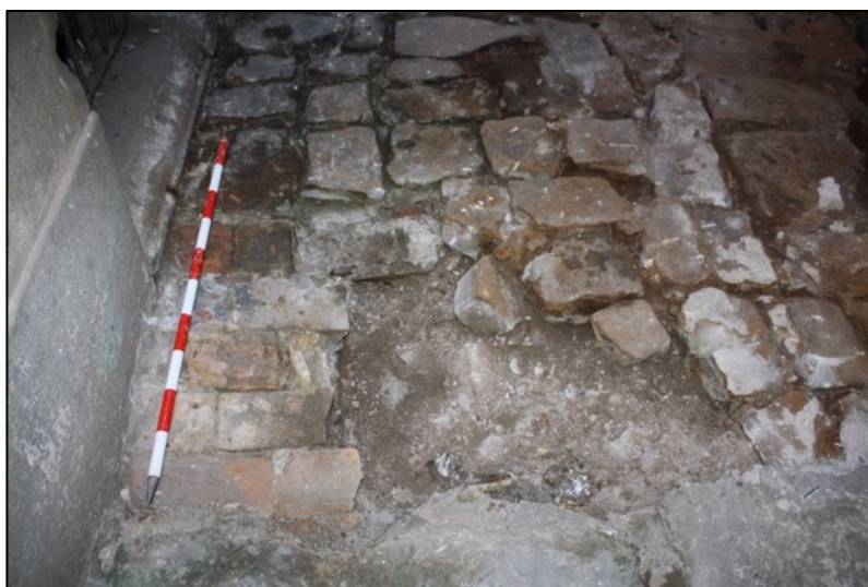
Fotografia 145. Retall que afecta el paviment UE305.
