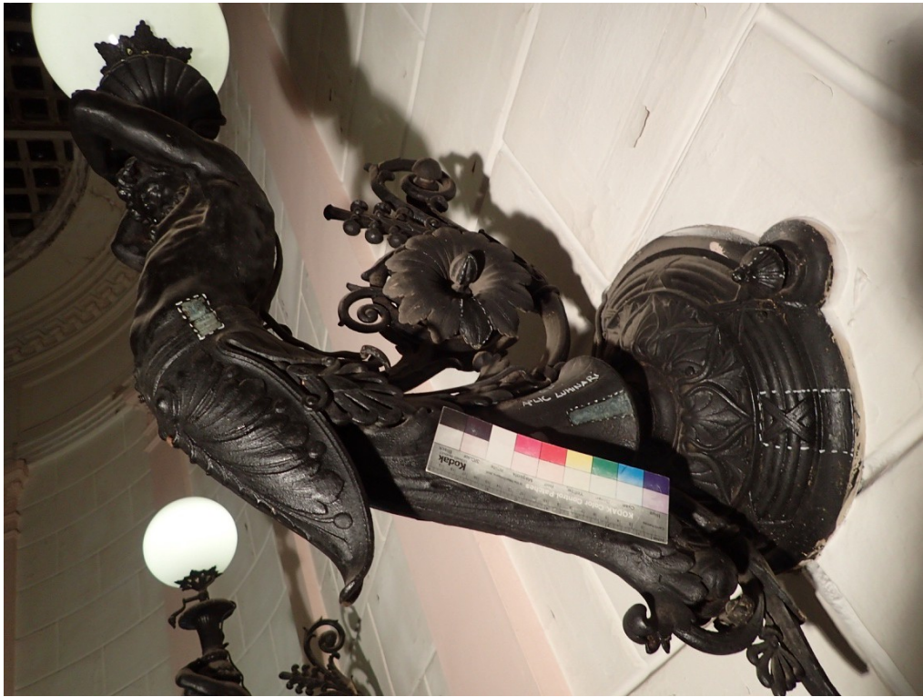
Apliques de ferro fos i llautó , amb pàtines d'imitació bronze antic oxidat.
