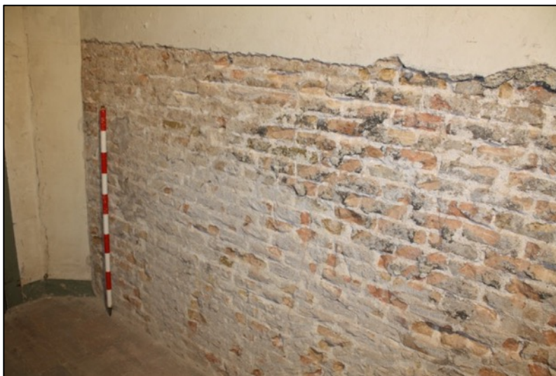
Fotografia 271. Mur de maons i morter de calç blanca ja documentat en la planta baixa UE1010 datat a mitjans del segle XIX.
