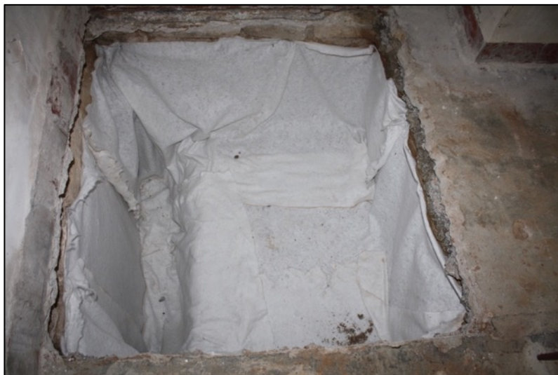
Fotografia 13. Cobriment de la cala K2 amb geotèxtil.
