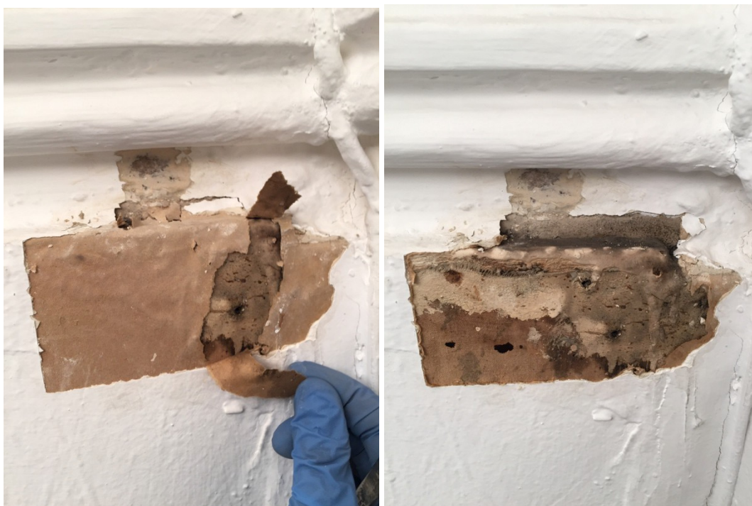
Detall de cala realitzada a l'àmbit 10 on es va documentar el paper i les teles clavades per lluitar amb les humitats de capil·laritat.
