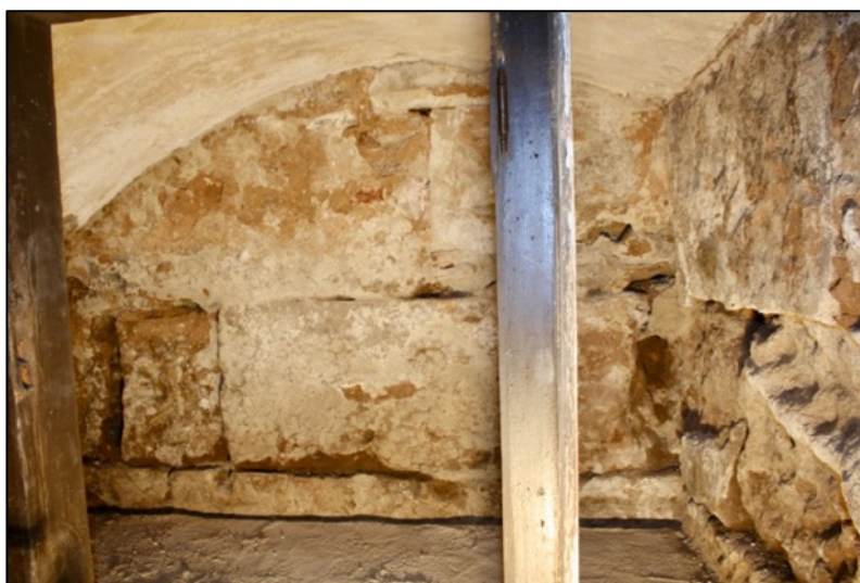
Fotografia 242. Reparacions finals s. XV-XVI realitzades al parament de la muralla, UE4003.
