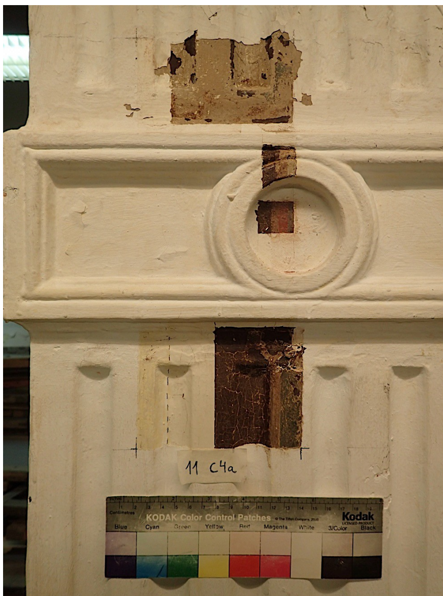
Colors d'imitació marbre damunt de capes de preparació del ferro colat per rebre la pintura.
