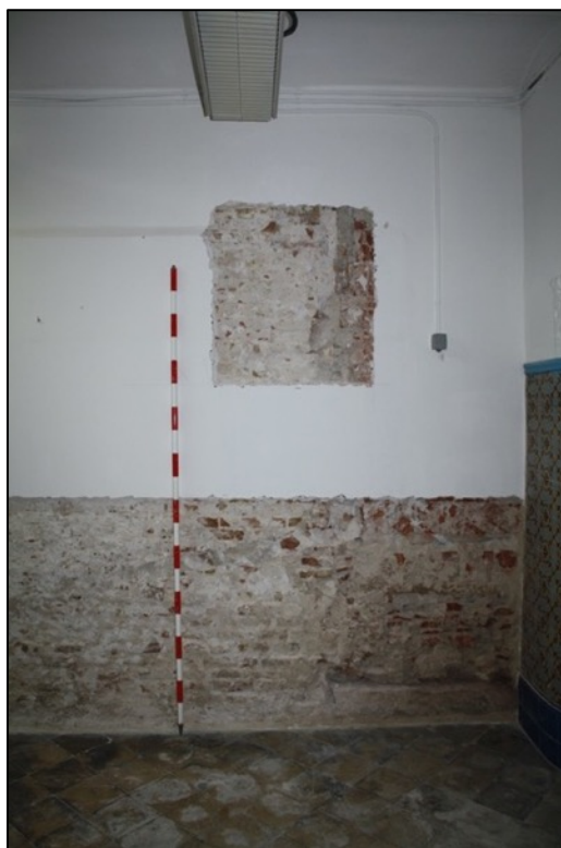
Fotografia 269. Ampliació longitud del mur original en el moment de construir el Borsí, UE2017.
