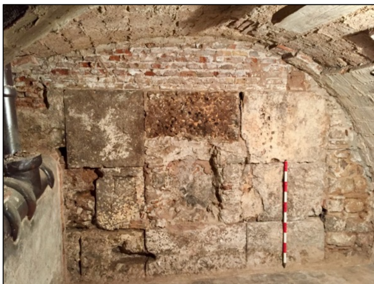
Fotografia 188. Vista frontal de l' opus quadratum de la torre 48.
