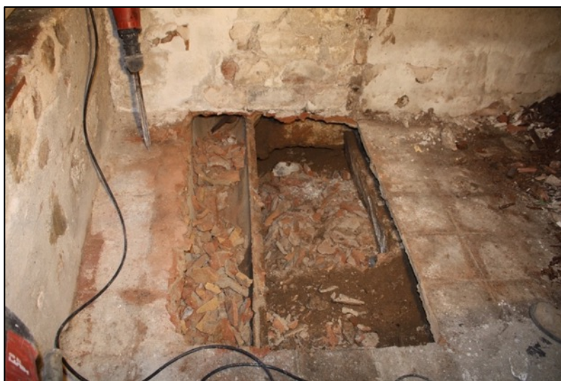
Fotografia 104. Claveguera de formigó UE220 i estrat UE221.
