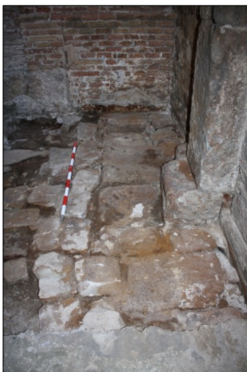
Fotografia 141. Claveguera UE303 amb coberta de lloses de pedra.
