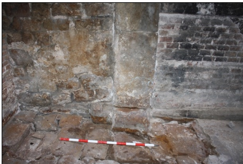
Fotografia 143. Vista dels murs del car Palau 4, UE321 i Avinyó 23 UE319.
