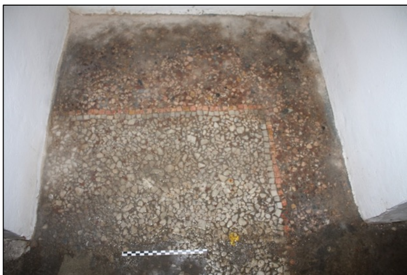
Fotografia 47. Detall del paviment UE277 fet amb terratzo continu.
