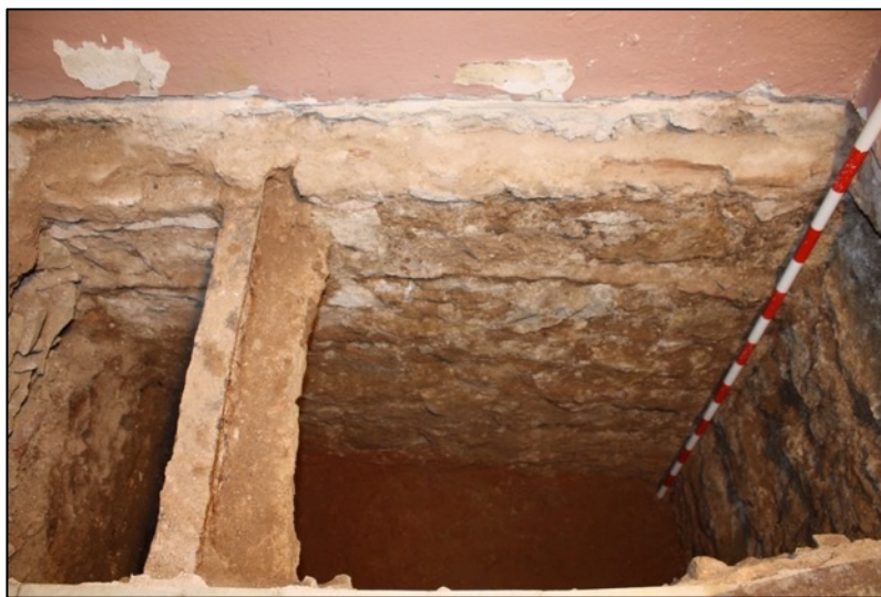
Fotografia 18. Vista fonamentació mur façana carrer d'Avinyó UE167.
