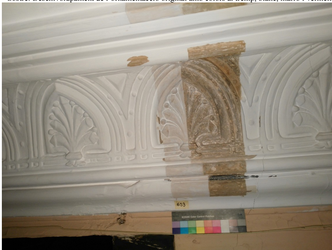
Detall un cop eliminades les capes monocromes de pintura plastica blanca, una al tremp gris clara i l'original amb colors al tremp, blanc, marró i vermell
