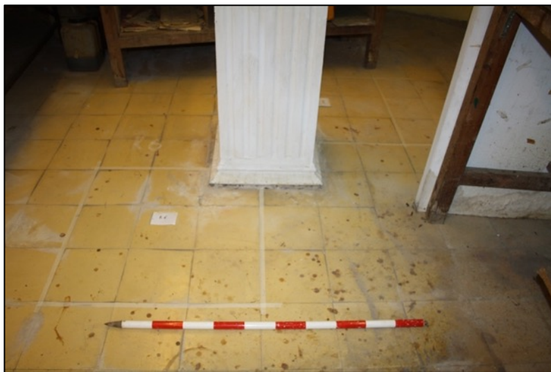
Fotografia 37. Paviment rajoles hidràuliques UE140.
