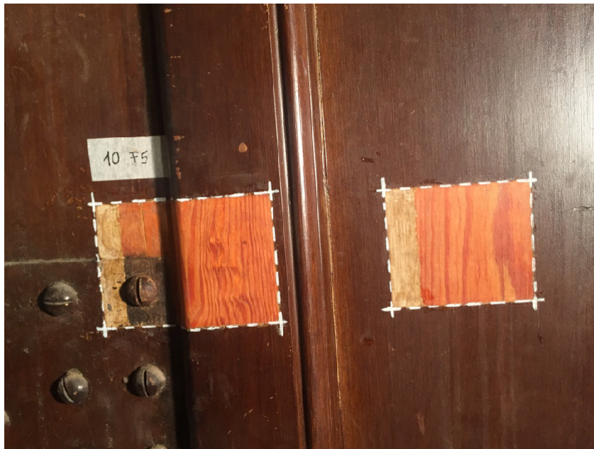
Fusteria: porta de pi melix amb pintura imitació fusta noble com acabat. La capa blanca és la preparació de la fusta per la pintura d'imitació.
