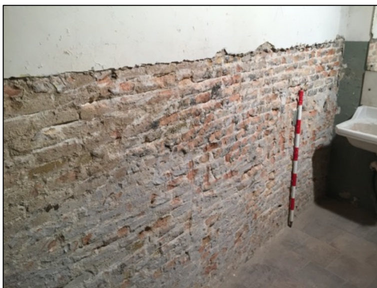
Fotografia 272. Vista del mur UE1010 aixecat per sobre de la cota d'arrasament de la torre 49 4n 4l moment de construir la finca Palau $ a mitjans del segle XIX.
