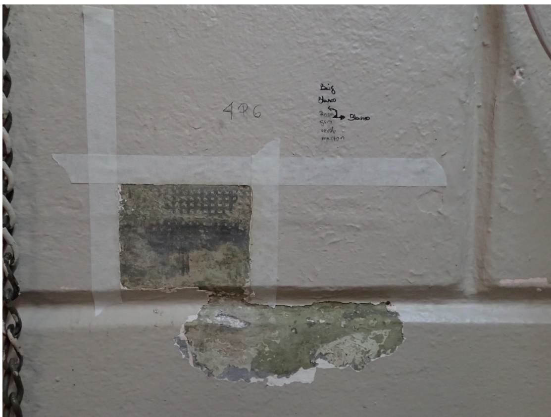
Parets: Estucat imitació carreus abuixardats de pedra gris fosca. Estat de conservació molt degradat.
