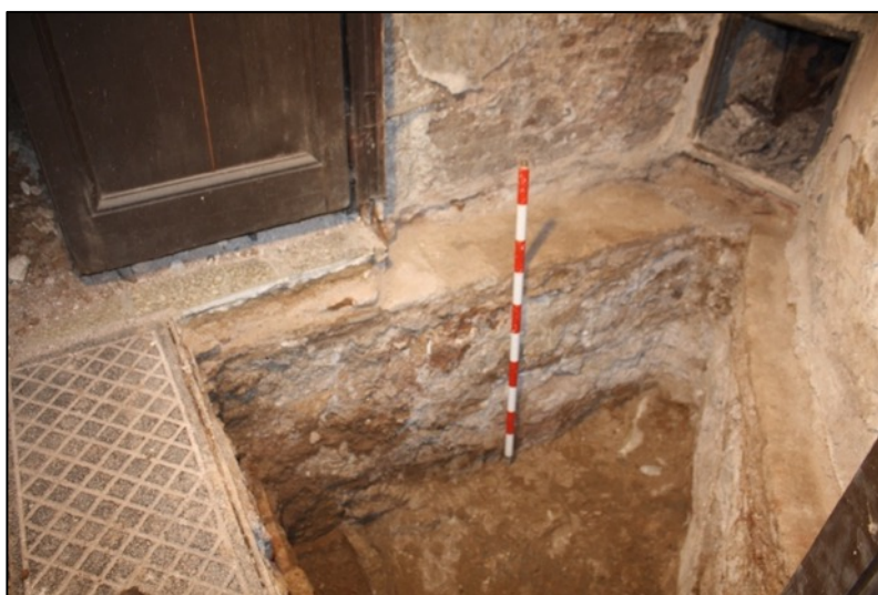
Fotografia 69. Fonamentació mur UE205.
