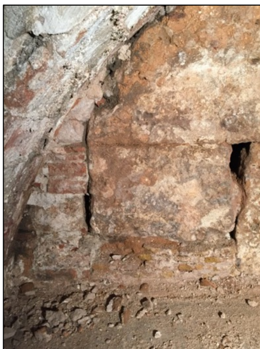
Fotografia 230. Petit mur de maons lligats amb morter de calç blanca adossat a la torre, UE1026. Datat al segle XVII-XVIII.
