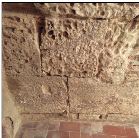
Fotografia 203. Detall opus quadratum de la torre 49 amb convivència de carreus en molt bon estat de conservació amb d'altres fortament erosionats.
