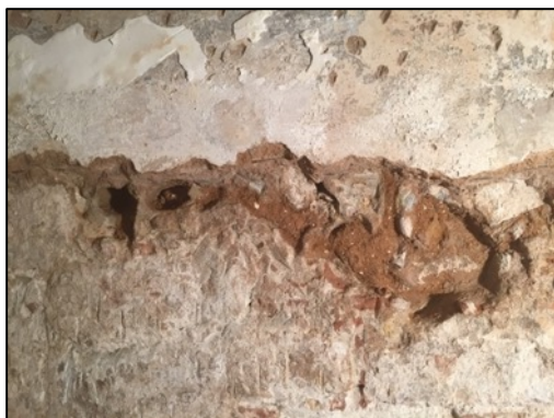
Fotografia 162. Reparació del mur de la torre en el segle XVI.
