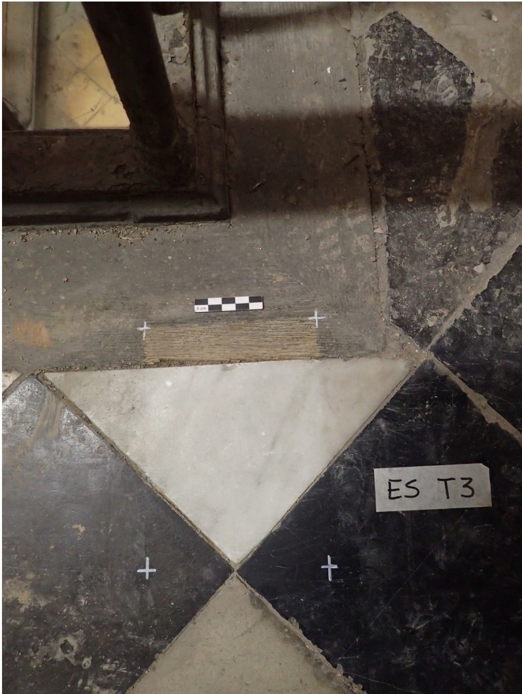
Paviment original de plaquetes de marbre blanc Macael i marbre negre Marquina.
