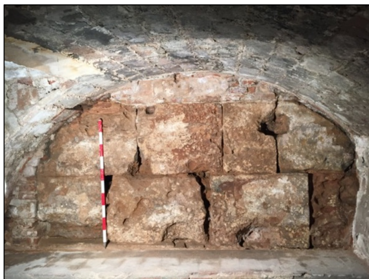
Fotografia 235. Opus quadratum del lateral oriental de la torre 49.
