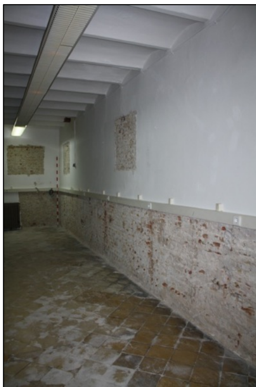
Fotografia 286. Repicat en la franja inferior del mur per localitzar el pany de muralla. Aquesta no es conserva en la zona d'entresòl.
