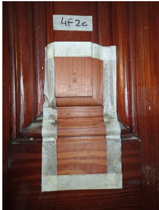
Fusteria de porta de noguera clara i contrafinestra de pi melix envernissat amb gomalaca.
