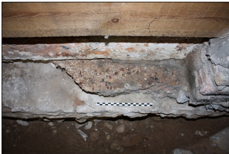
Fotografia 85. Paviment de terratzo continu UE210.
