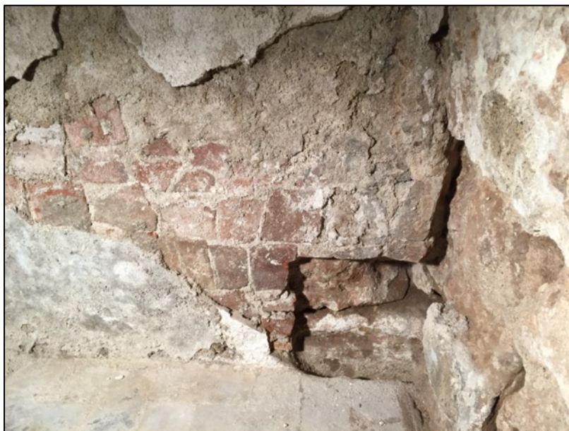
Fotografia 239. Vista de l'aplatat de maons UE4002 amb pany de muralla UE4000.
