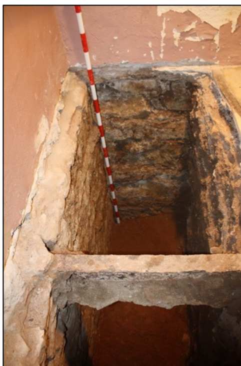
Fotografia 19. Vista fonamentació mur façana carrer d'Avinyó UE165.
