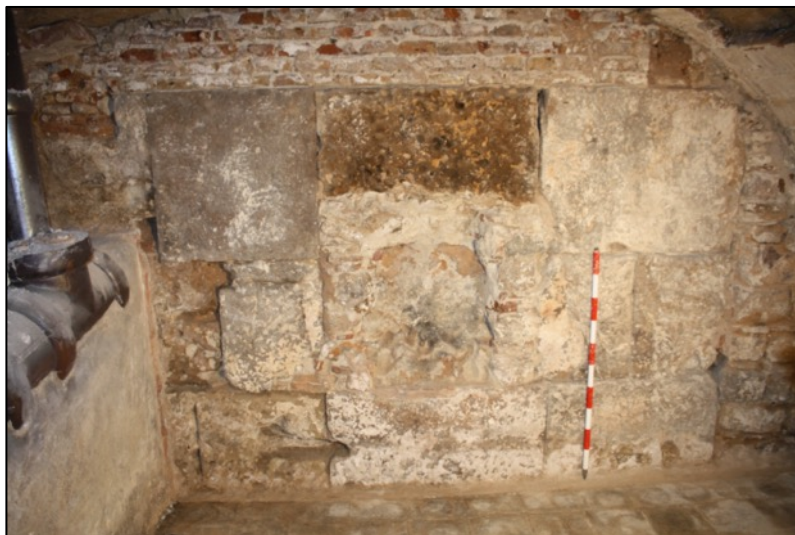
Fotografia 180. Estructura de combustió excavada en el parament de la torre 48 UE2007.
