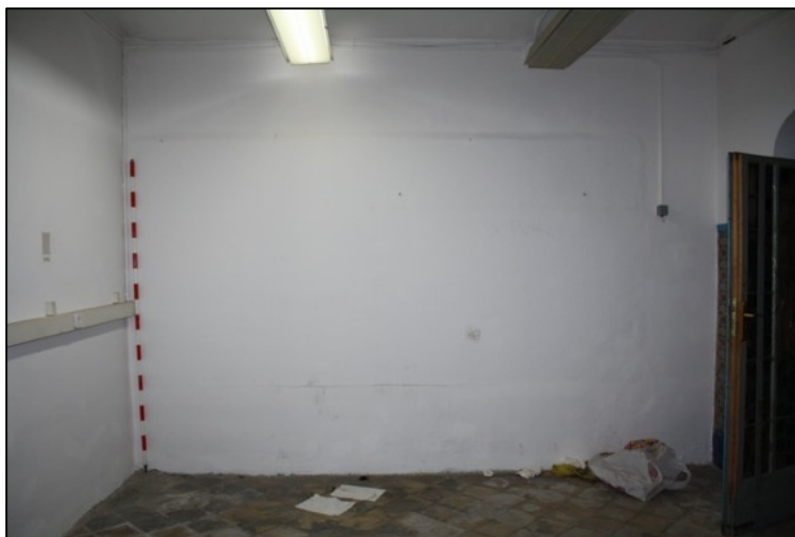
Fotografia 266. Restes actuals: capa de pintura blanca, UE2015 i capa de guix, UE2016.
