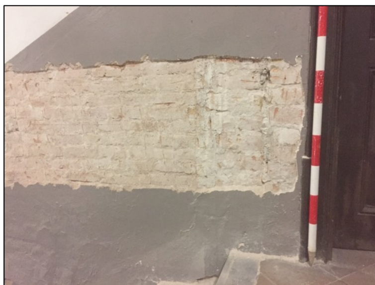
Fotografia 166. Detall del mur de maons documentat, UE1009.
