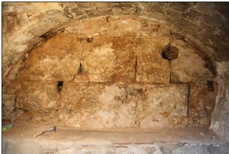
Fotografia 225. Vista opus quadratum lateral oriental torre 49.
