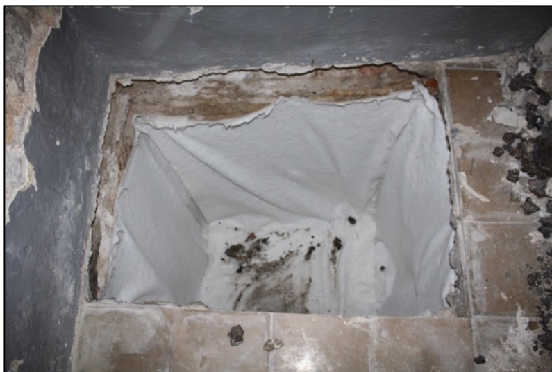
Fotografia 115. Cobriment de la cala K13 amb geotèxtil.
