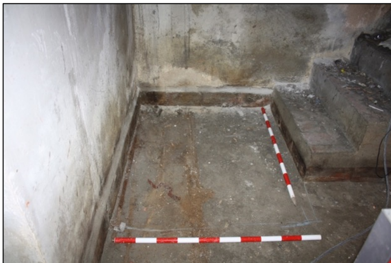
Fotografia 1. Paviment de formigó UE100.
