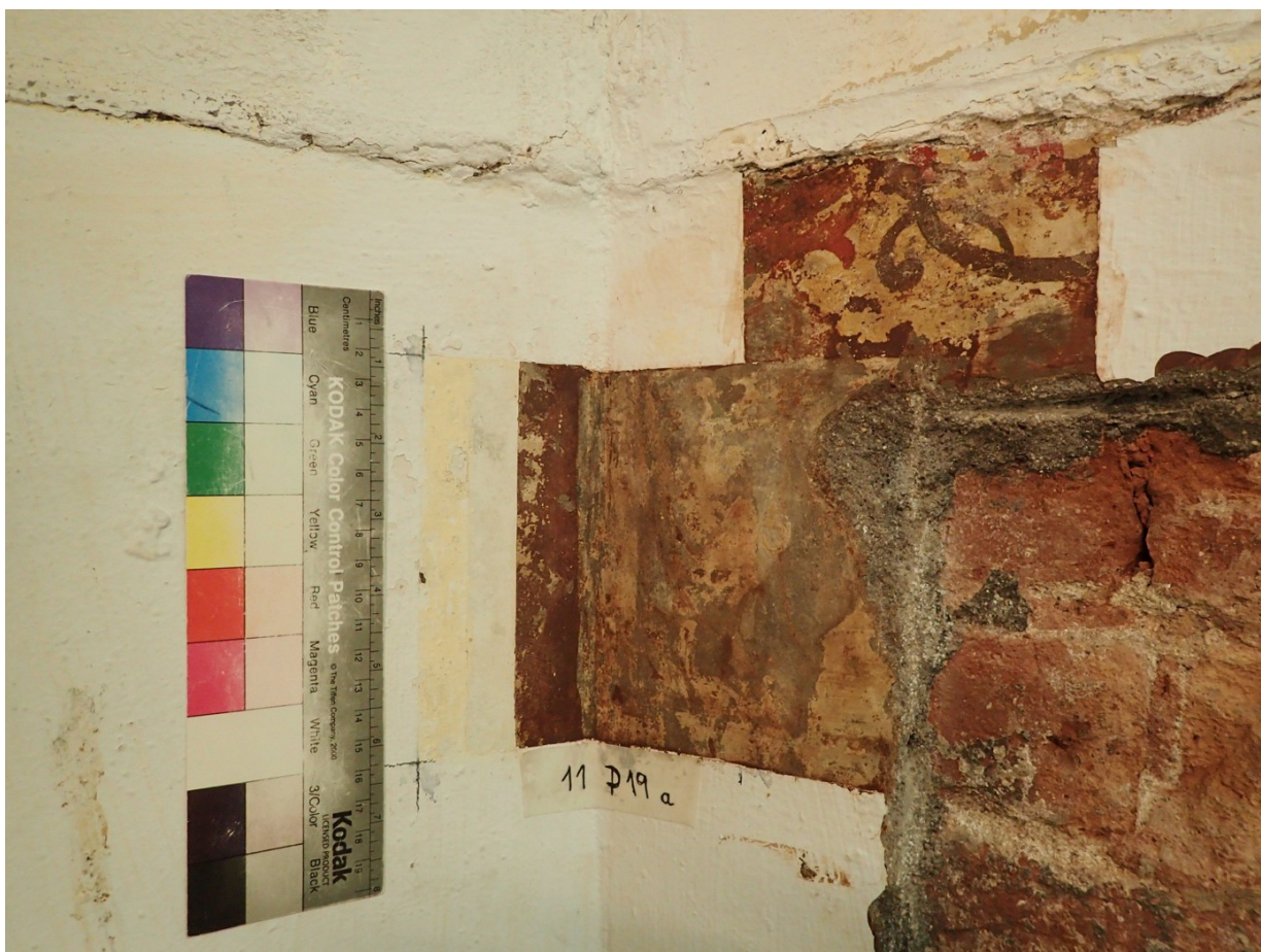
Restes de capes de pintura ornamental aplicada damunt de revestiment de ciment.
