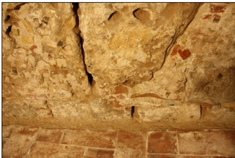
Fotografia 205. Detall encaix per a la col·locació dels carreus de la torre 49.
