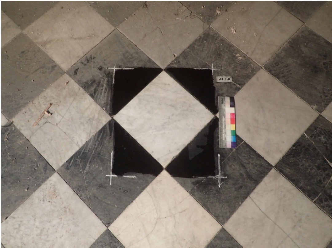
Paviment: escacat de plaquetes de marbre.
