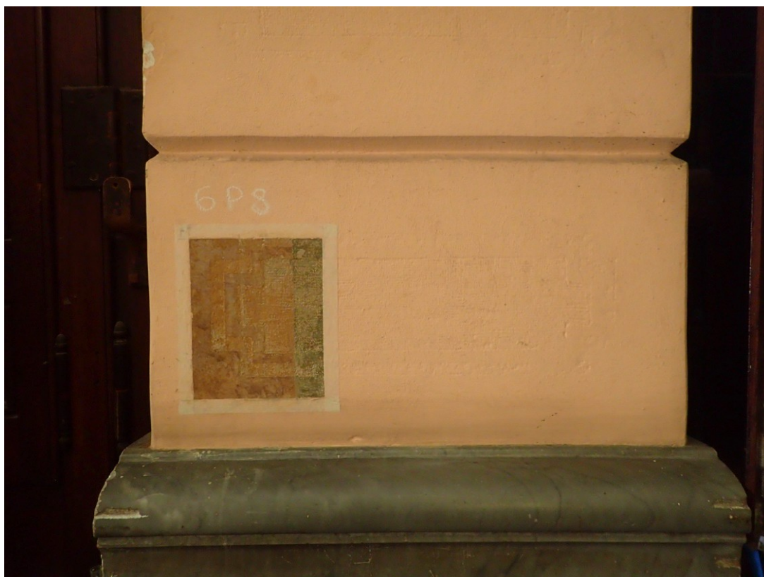
Parets amb estuc, planxat al foc, imitació marbre. Posteriorment pintat de gris verdós i finalment amb pintura plàstica rosa.
