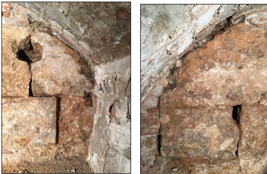
Fotografies 234 i 234. Detalls de les reparacions finals s. XV-XVI al parament, UE1009.
