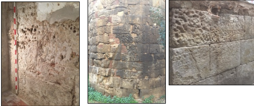
Diversos exemples de l'erosió per salitre documentada en la muralla baiximperial. A l'esquerra frontis de la torre 49 documentada a l'Antic Borsí, al centre la torre 33 a la plaça dels Traginers i a la dreta la torre 28 al carrer Sotstinent Navarro.
