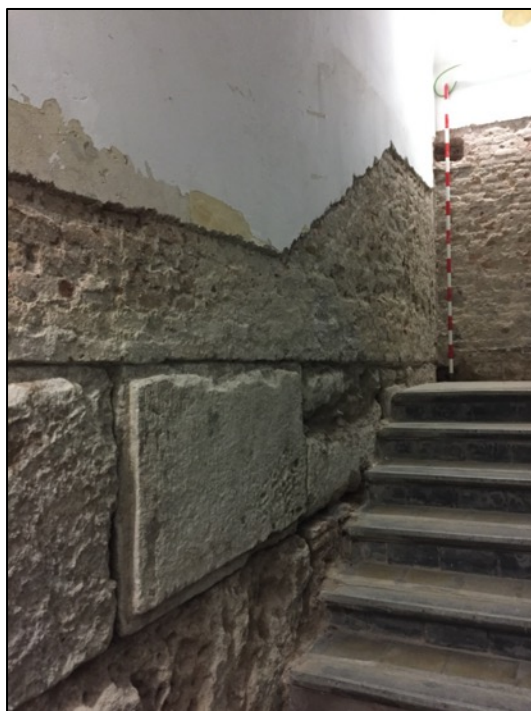
Fotografia 260. Cota d'arrasament del tram de muralla entre torres 49 i 50 amb mur de maons de mitjans s. XIX de la finca veïna Palau 4 UE4009.
