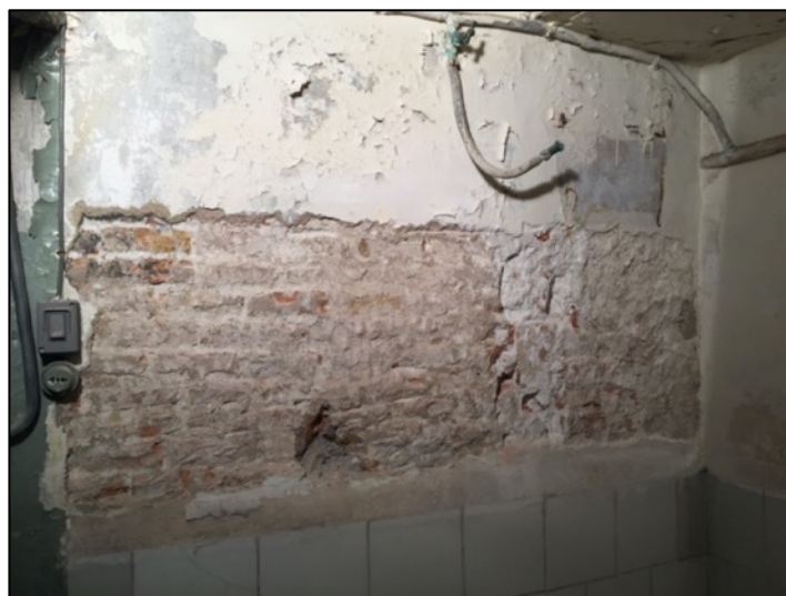
Fotografia 274. Mur de maons UE1010 amb una reparació més recent en la zona de l'extrem de la cala, UE1031.
