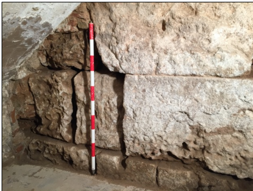
Fotografia 247. Carreus amb gran afectació per l'erosió.
