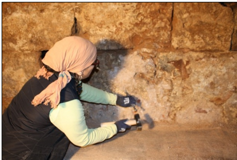
Fotografia 227. Extracció restes de ciment ràpid que afecten la torre 49.
