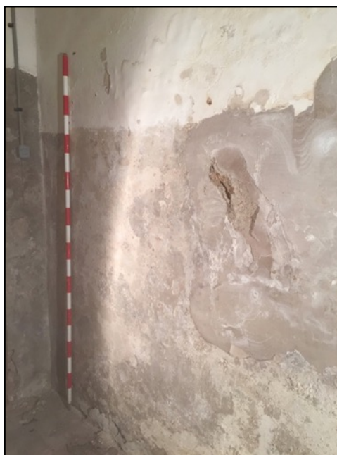
Fotografia 153. Revestiments contemporanis del mur on s'ha realitzat la cala AA1 UE1002 i UE1004.
