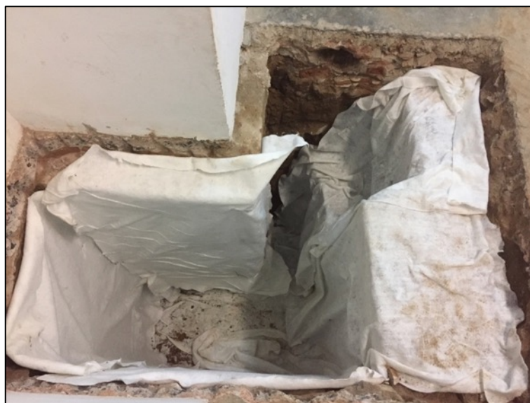
Fotografia 55. Cobriment de la cala K7 amb geotèxtil.
