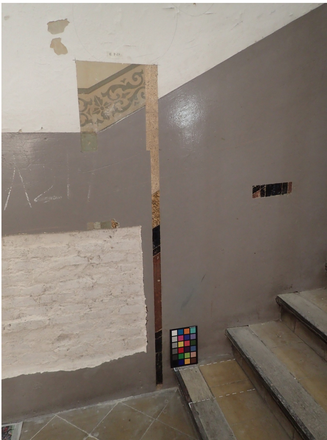
Sòcol estucat d'imitació marbre i carreus imitació granit amb el color originals. Escala amb graons de combinació de rajola hidràulica i fusta de roure. Sanefa ornamental del sòcol en tons verds i grisosos.
