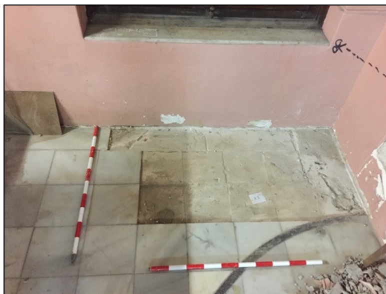
Fotografia 15. Preparació de calç UE160.
