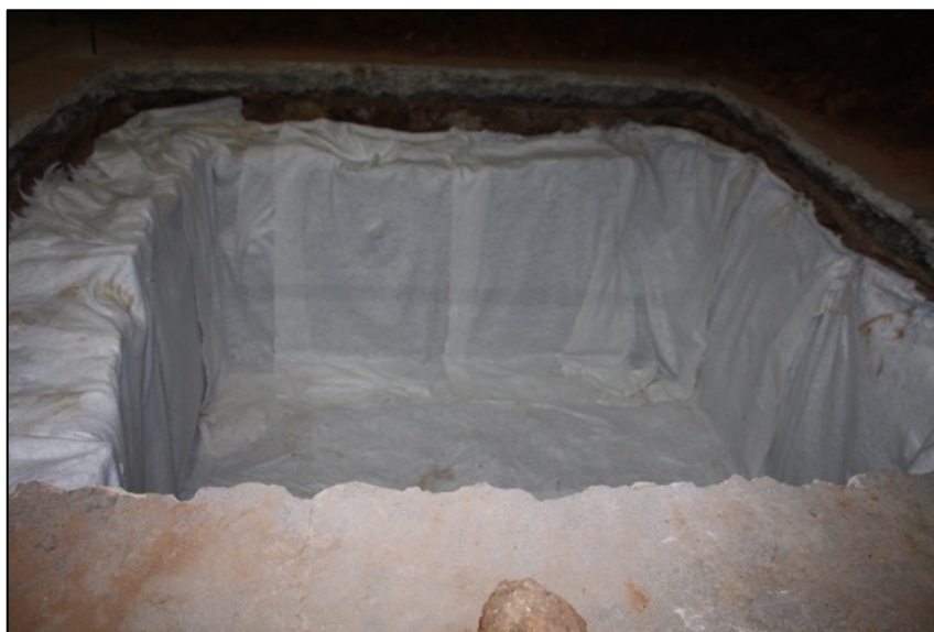
Fotografia 137. Cobriment de la cala KA1 amb geotèxtil.
