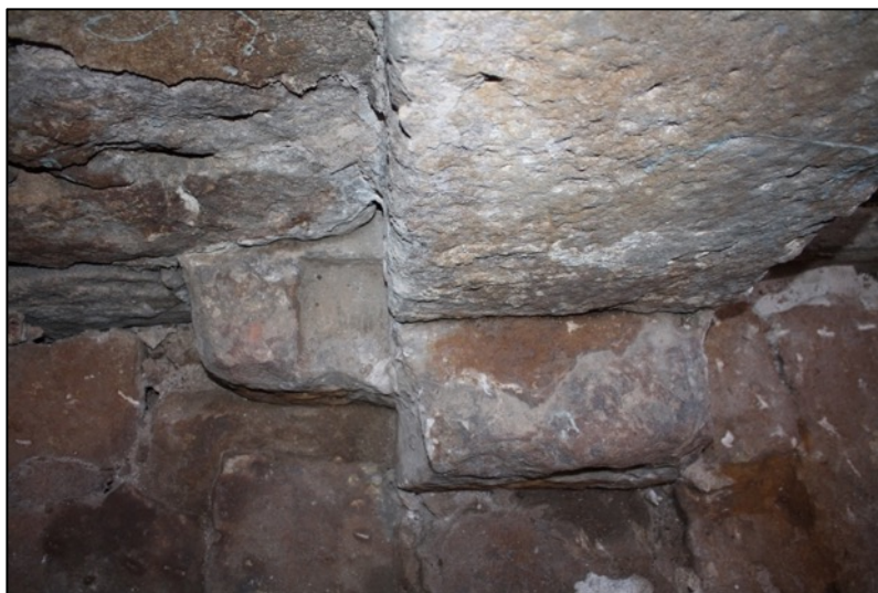
Fotografia 146. Detall encaix en un dels carreus reaprofitats de la muralla romana.
