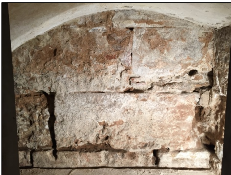
Fotografia 240. Vista del pany de muralla UE4000 un cop extret l'aplatat de maons contemporani.
