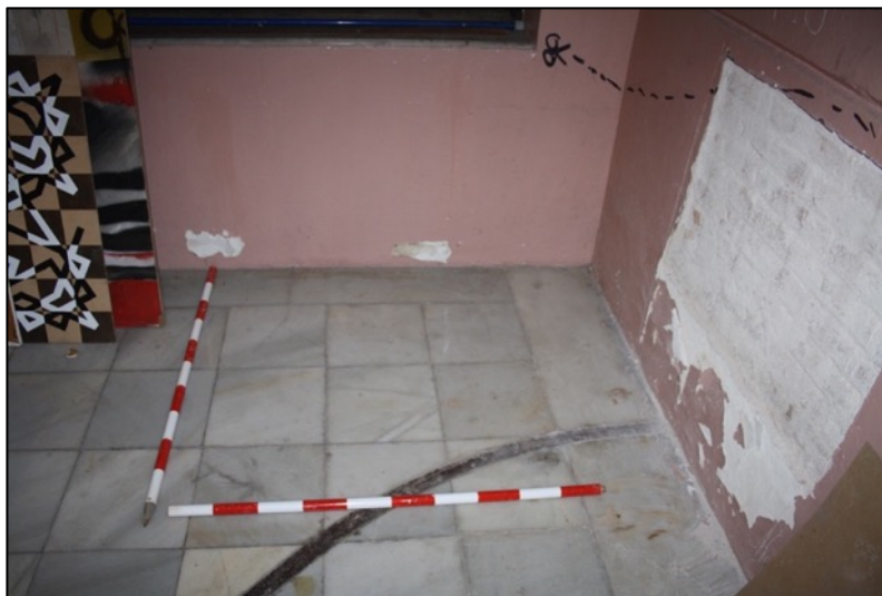
Fotografia 14. Paviment de marbre UE159.
