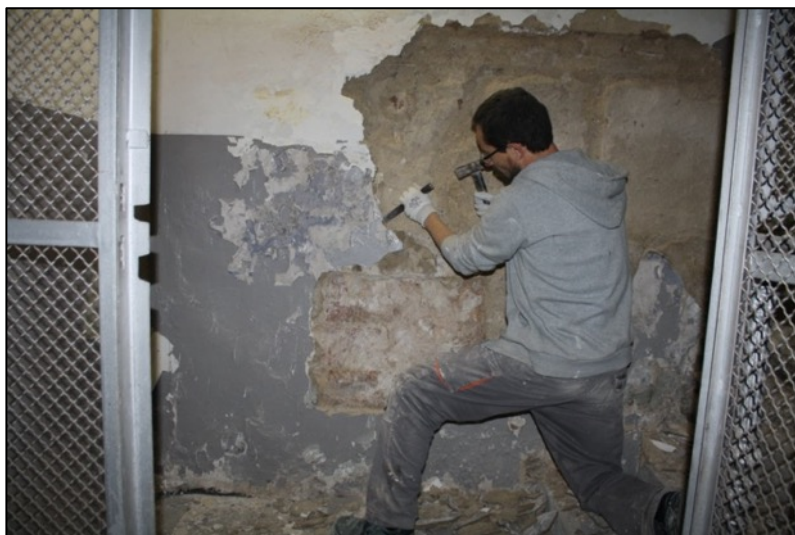
Fotografia 254. Visió de com apareix l' opus quadratum de la muralla just a l'enretirar les capes actuals.
