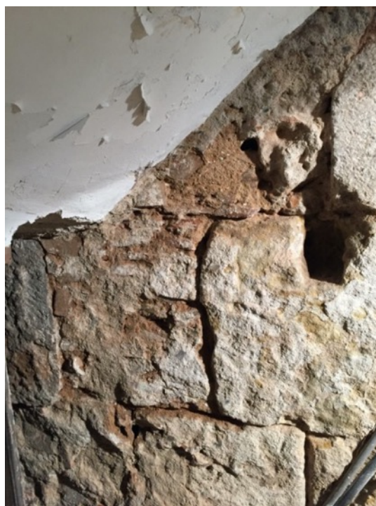
Fotografia 213. Reparació amb morter de sorra i calç del parament de la muralla, UE1008.
