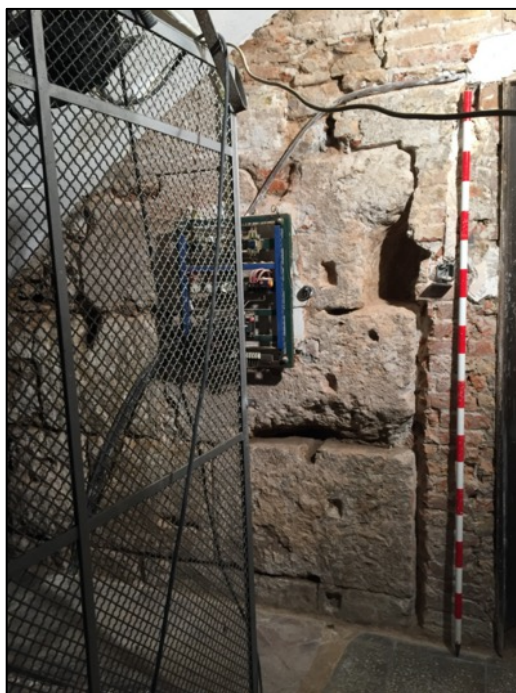
Fotografia 212. Mur de maons UE1020 aixecat per sobre la cota d'arrasament de la torre 49. Relacionat amb la construcció de la finca Plau 4.
