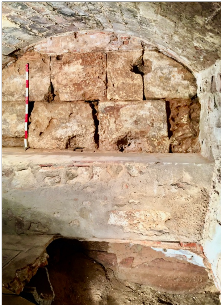
Fotografia 236. Vista completa del lateral oriental de la torre 49 amb el tram documentat en els treballs de repicat i la cala K12.
