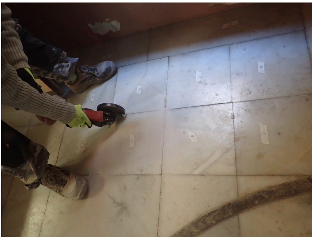
Treballs d'extracció controlada amb numeració de plaques per realitzar les cales estructurals.
