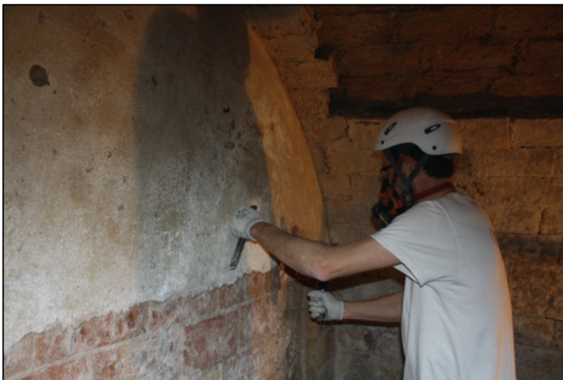
Fotografia 176. Treballs d'aixecament de les fases contemporànies que cobreixen el lateral occidental de la torre 48 en fase de documentació.
