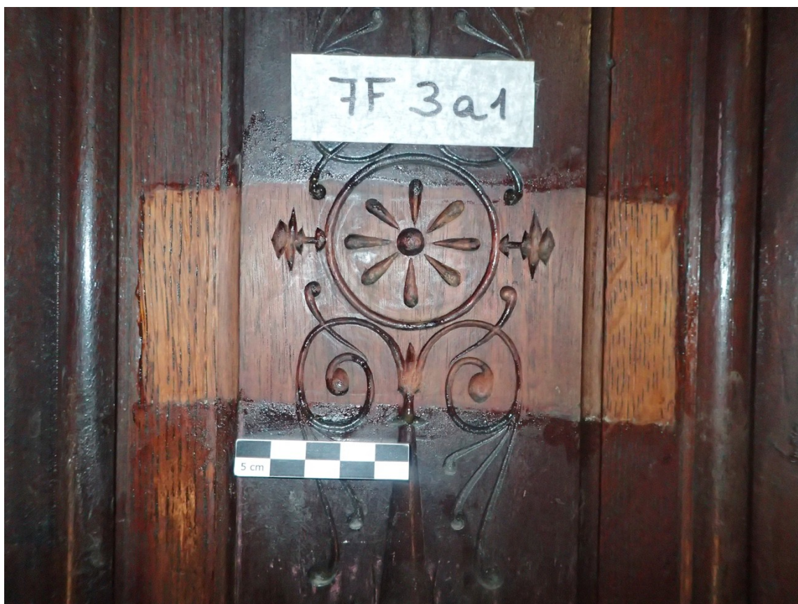
Fusteria: porta de roure i noguera envernissada originalment amb goma laca, i posteriorment amb vernís modern.
