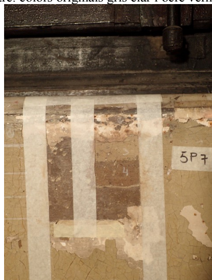
Estucat de paret de color gris fosc, amb les diverses capes de pintures esmalt damunt (només zona sócol)
