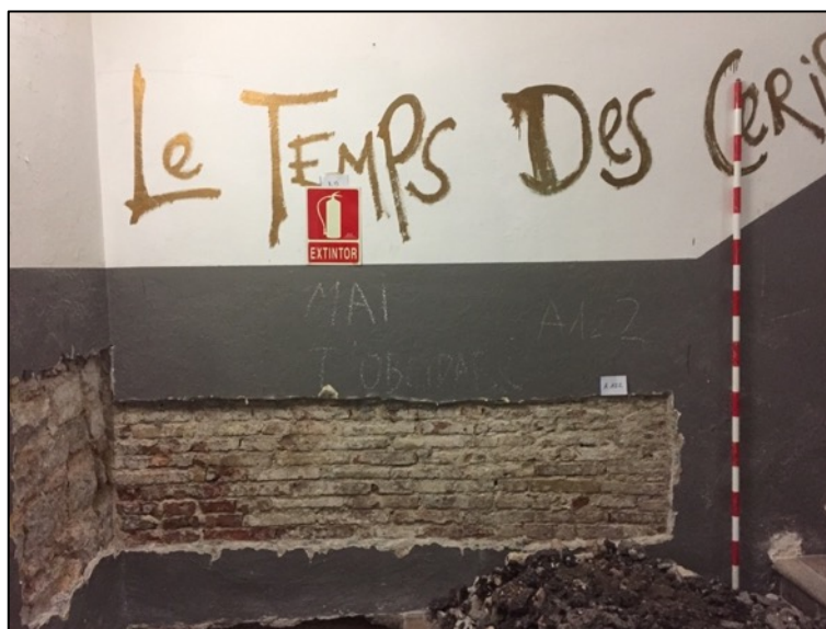
Fotografia 168. Mur UE265 fet amb maons i morter de calç.
