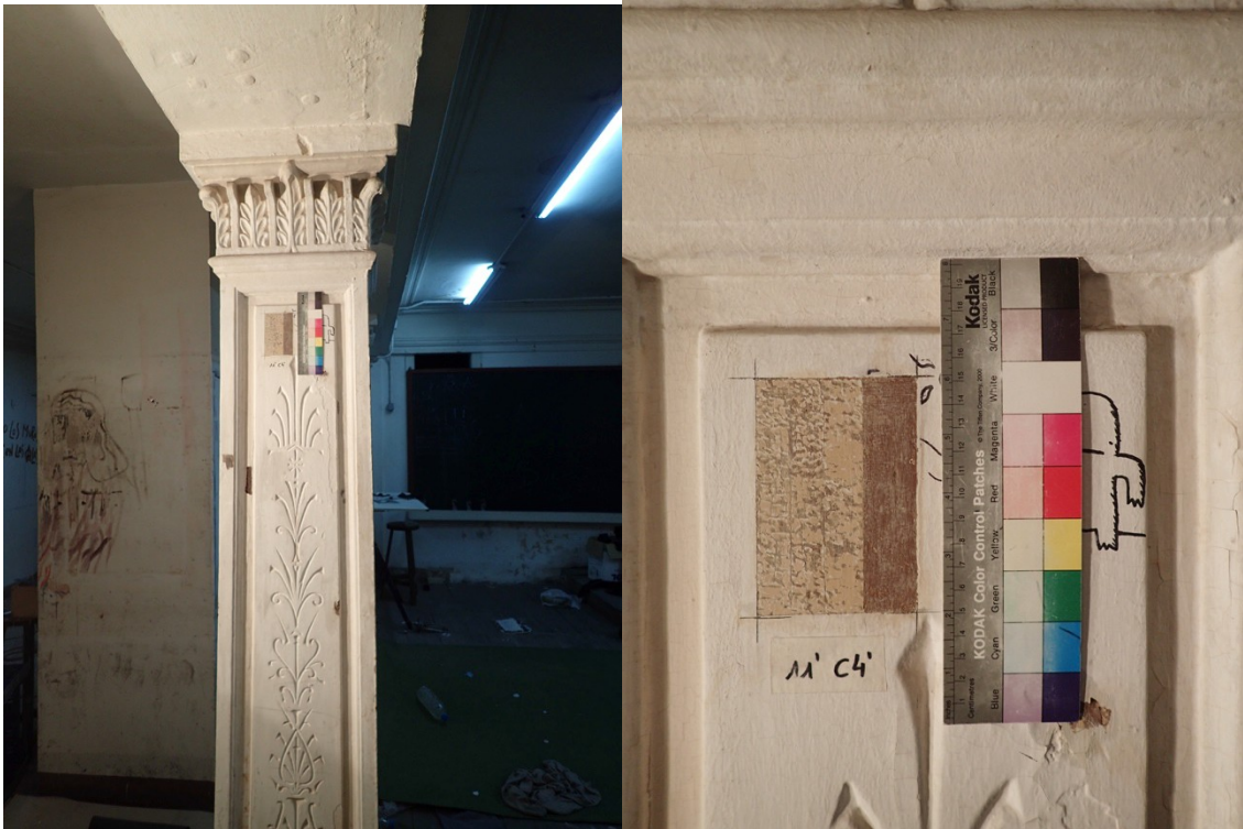
Columna de ferro colat amb la pintura original marró sota una capa de pintura ocre clar i la més moderna.
