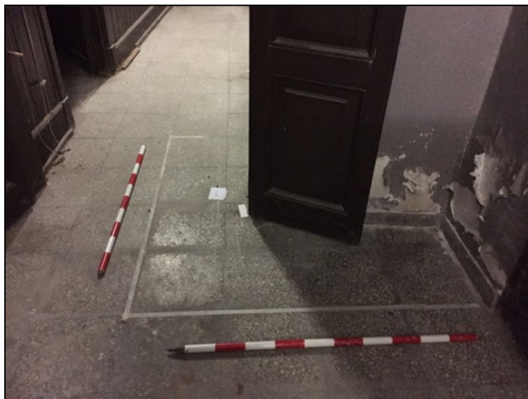
Fotografia 97. Paviment de rajoles de terratzo UE185.
