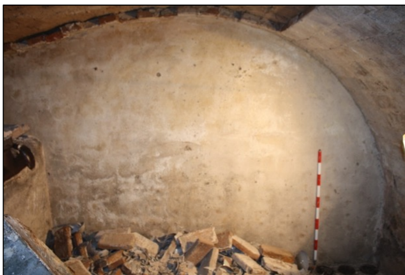
Fotografia 172. Restes de l'arrebossat actual del mur on s'ha realitzat el repicat en la cala AA2 en la planta baixa. UE2004.
