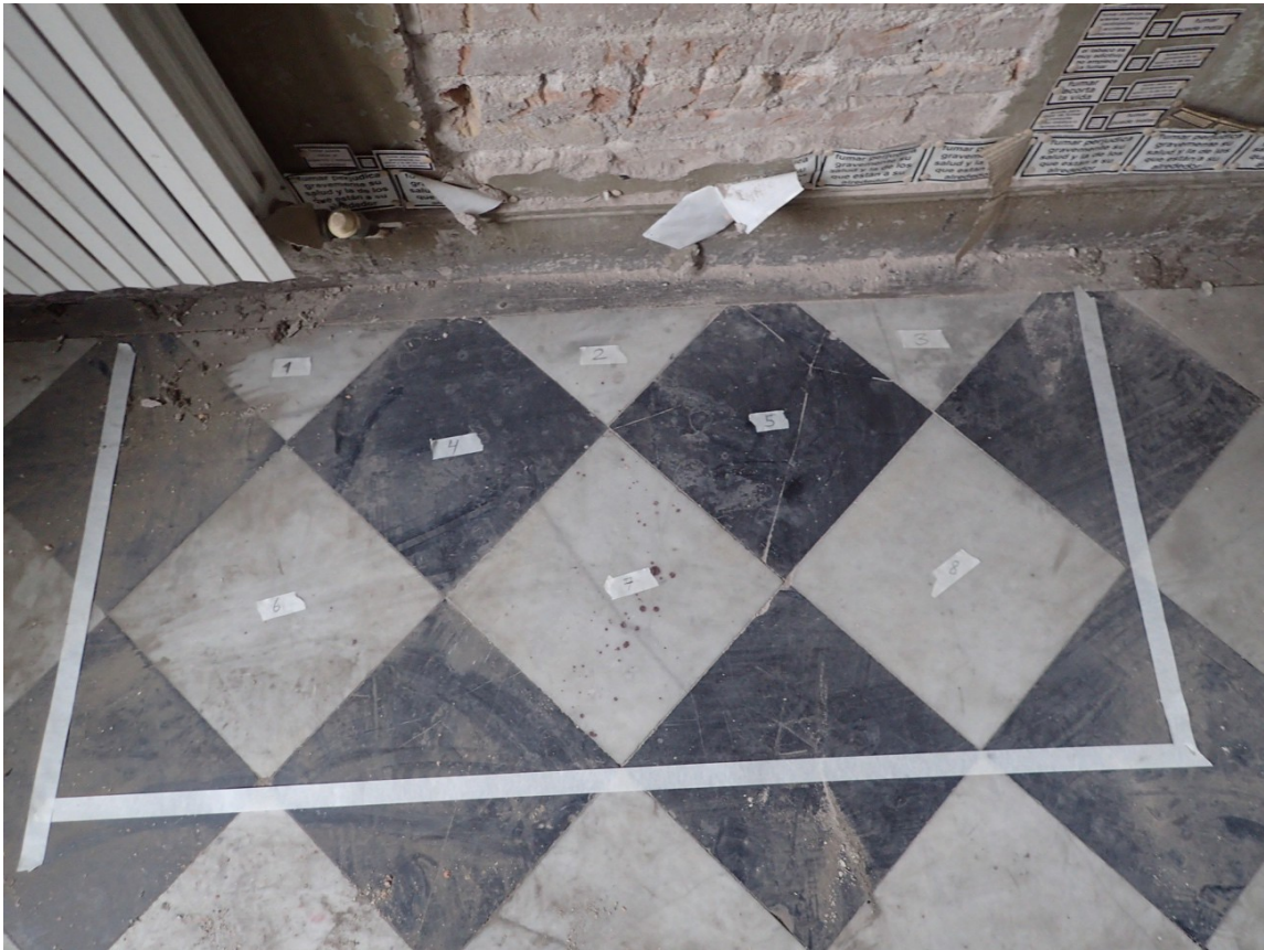
preparació per l'extracció de plaques de marbre per facilitar la cala d'estructures.
