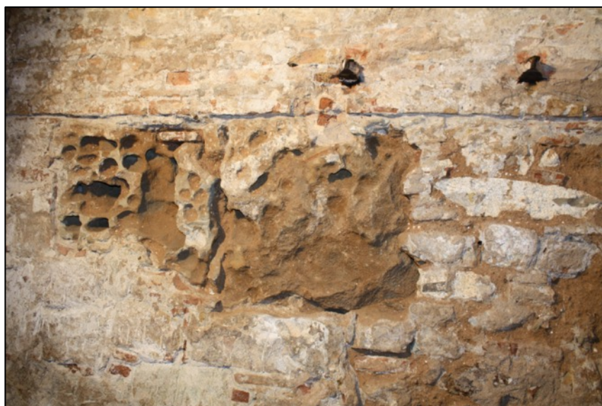
Fotografia 196. Detall reparació pany de muralla s. XIX UE1005.
