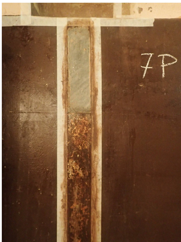
Sòcol d'estuc imitació marbre gris Macael, un cop decapades les pintures esmalt posteriors.
