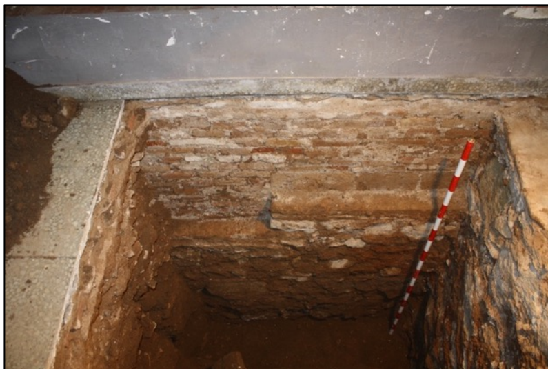
Fotografia 101. Vista del fonament UE189.
