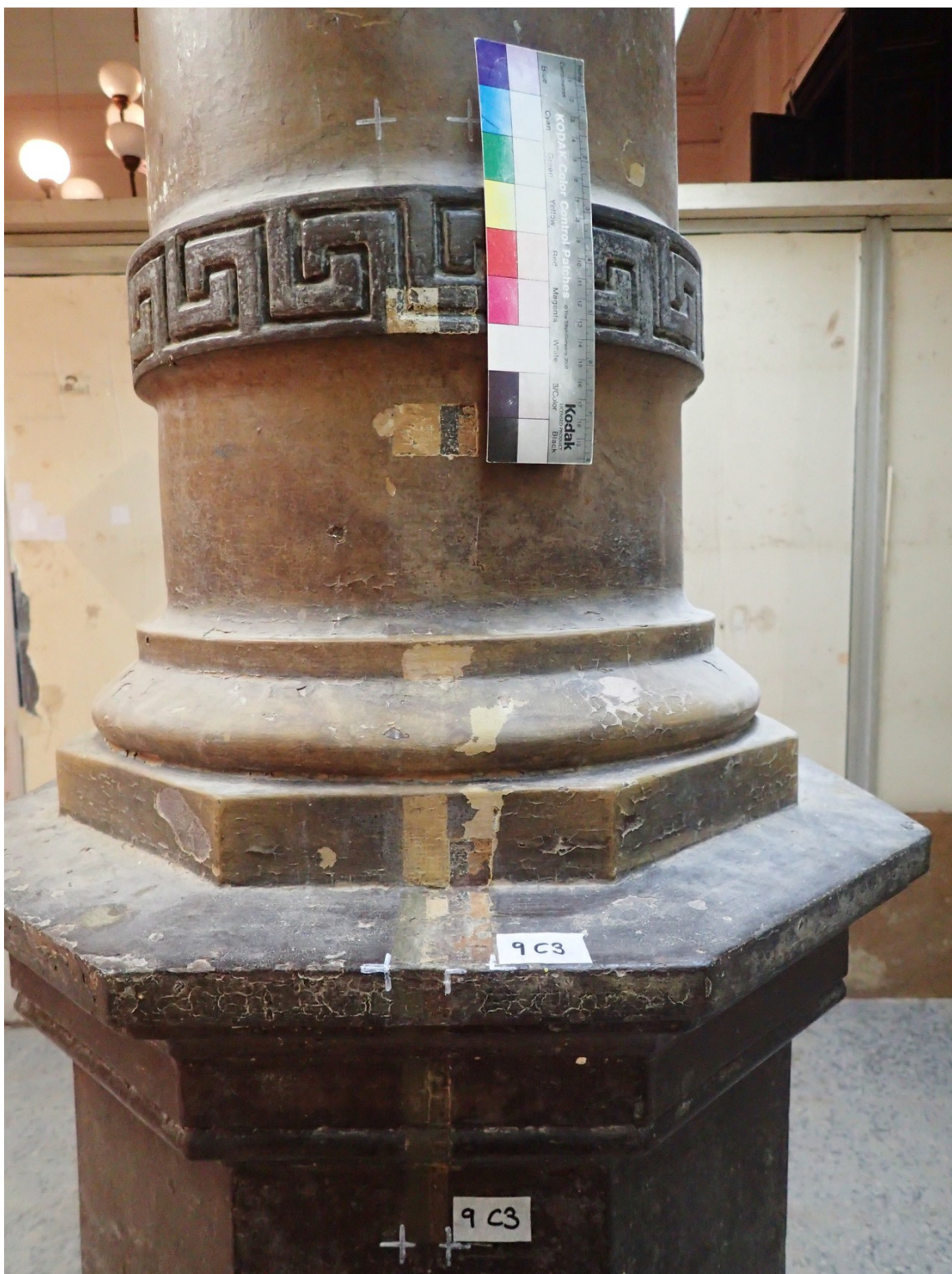
Columna de fossa amb pintura ornamental (probablement al oli) imitant marbres, sota capes de pintura de preparació per fer l'imitació.
