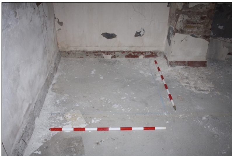
Fotografia 7. Llosa de formigó UE100.
