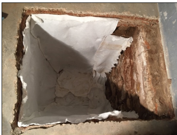
Fotografia 80. Cobriment de la cala K9B amb geotèxtil.
