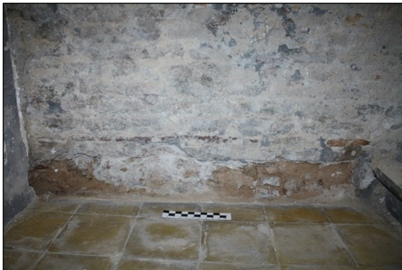
Fotografia 279. Restes de les reparacions de finals del segle XV-XVI en el parament de la torre 49, UE1008.
