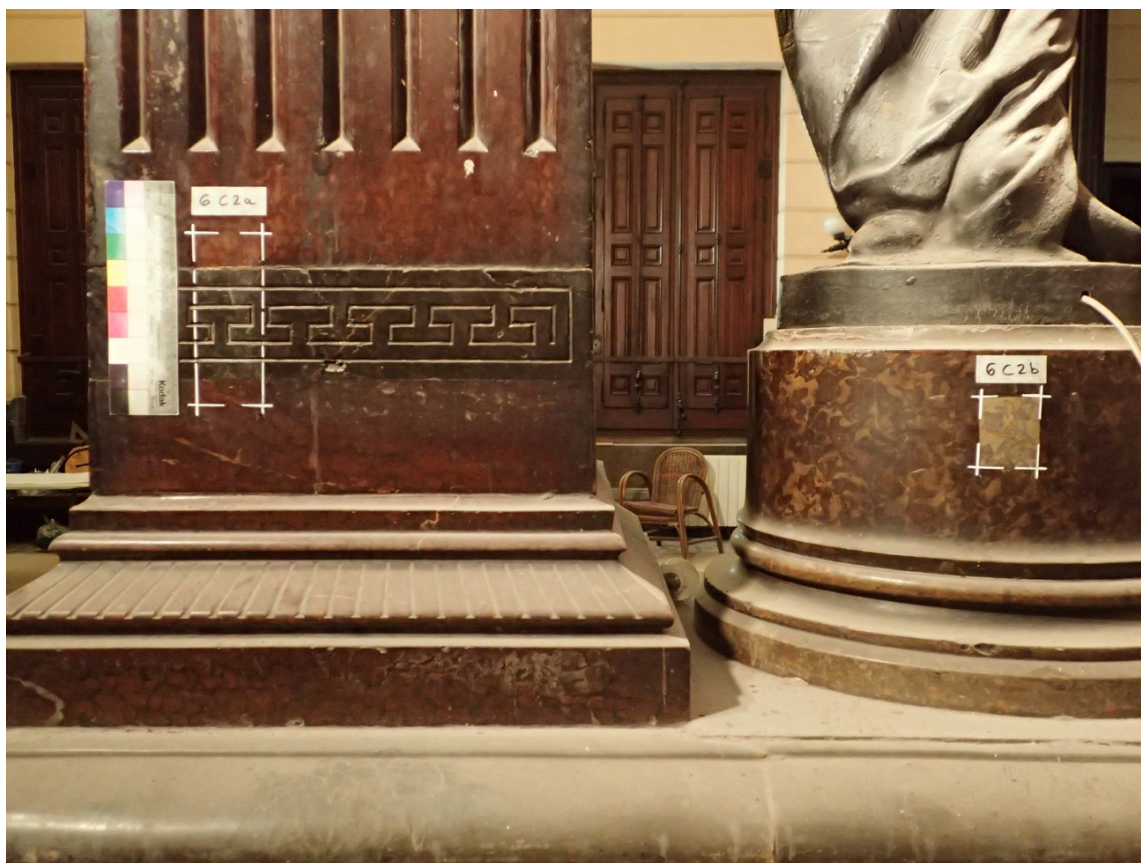
Pilars i bases de marbres espanyols de l'arc llevantí, gris Macael, Vermell Alacant i marró emperador.
