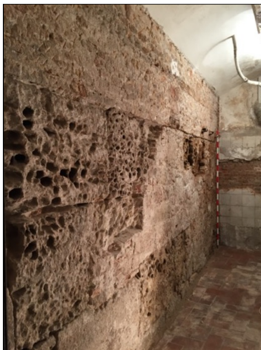
Fotografia 191. Vista frontis torre 49 des de la cantonada occidental.
