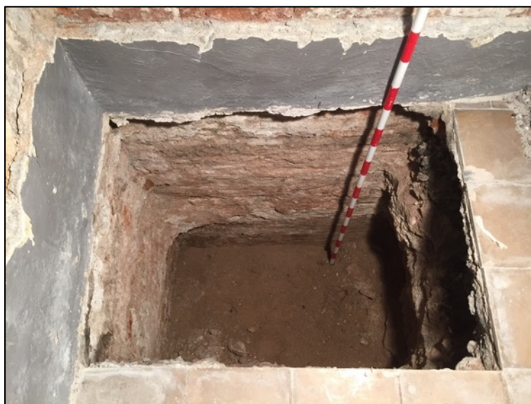
Fotografia 113. Estrat usat per pujar el nivell del terra per la construcció de l'escala del Borsí UE158.
