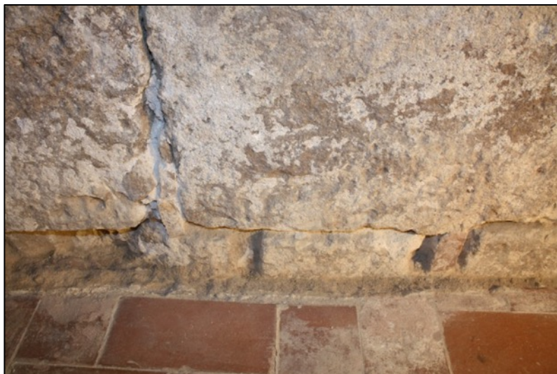
Fotografia 204. Encaixos en la part baixa del parament. Característics del procés de col·locació de les pedres.
