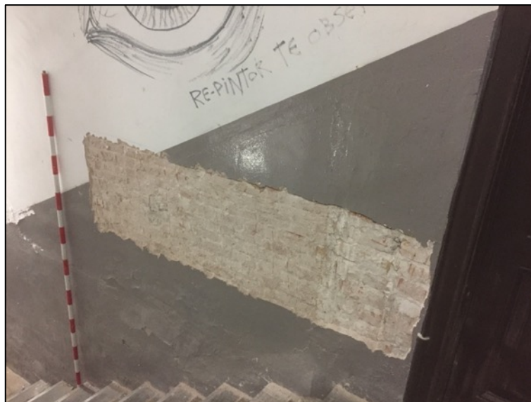
Fotografia 165. Cala AA1 el mur lateral de l'escala en la zona de l'entresol.
