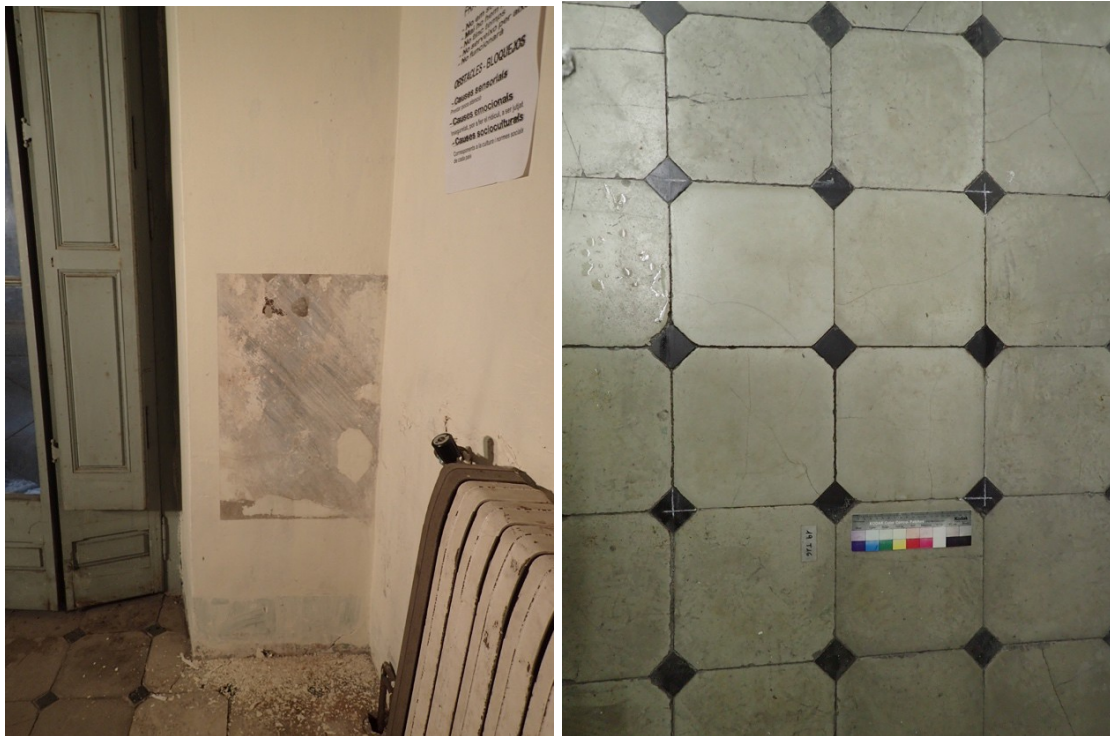
Sòcol amb estuc imitació marbre i paviment de peces hidràuliques blanc i negres.
