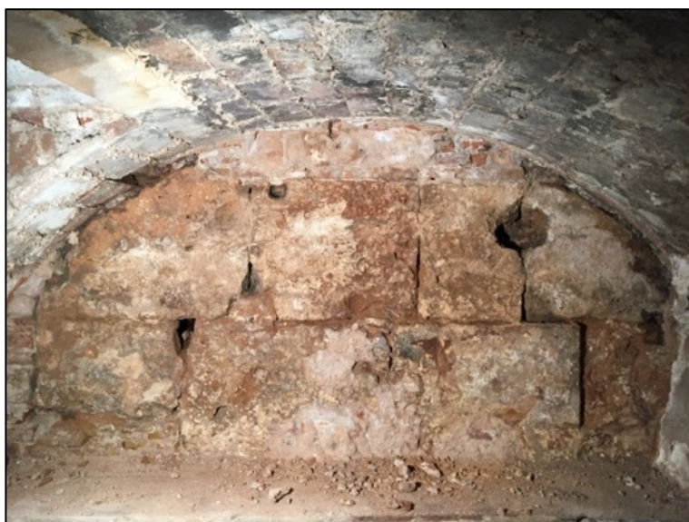
Fotografia 232. Reparacions fetes amb morter de sorra i maons, UE1009.
