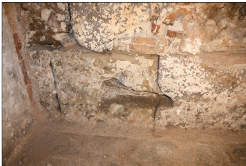
Fotografia 182. Detall encaix 2014 documentat en la part inferior del parament de la torre 48.
