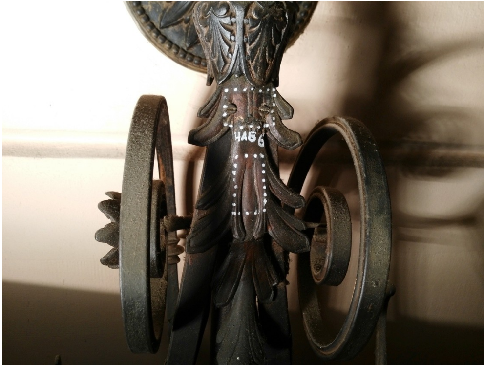
Pàtines de realçament dels aplics metàl·lics.
