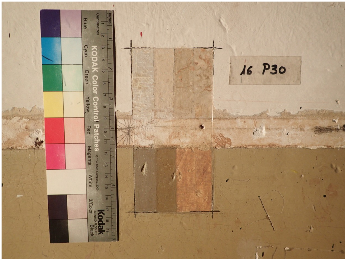
Parets: colors base amb sòcol de fusta desaparegut.
