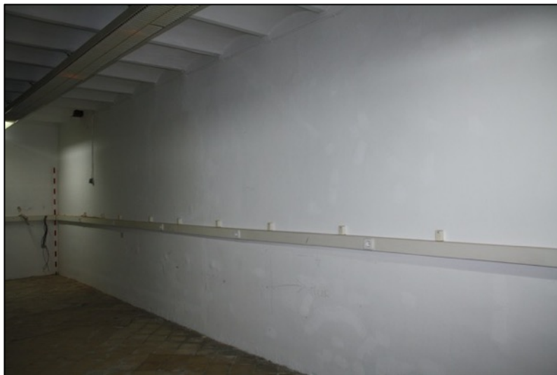
Fotografia 285. Vista del mur actual en la zona d'entre torres 48 i 49 amb capes de pintura contemporània UE UE3001 i nivell de guix UE3002.
