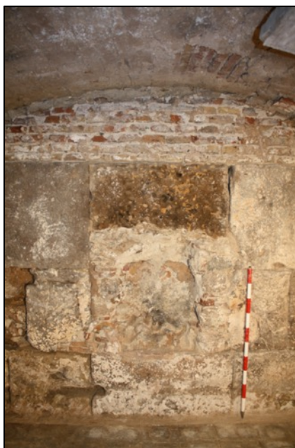
Fotografia 181. Detall estructura de combustió amb part construïda amb maons UE2008.
