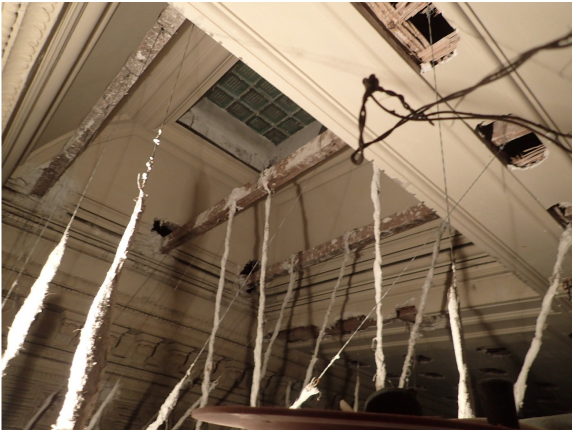
Sostre ocult entre la placa de guix actual i el paviment de la planta segona.
