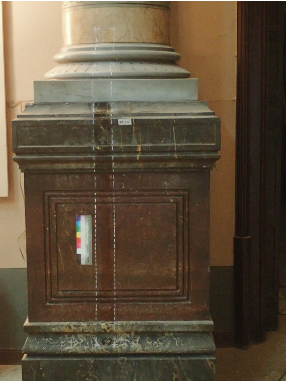
Columnes monolítiques de marbre Santa Tecla Tarragona, Gris Macael de Almería, Vermell Alacant i Emperador fosc de Murcia.
