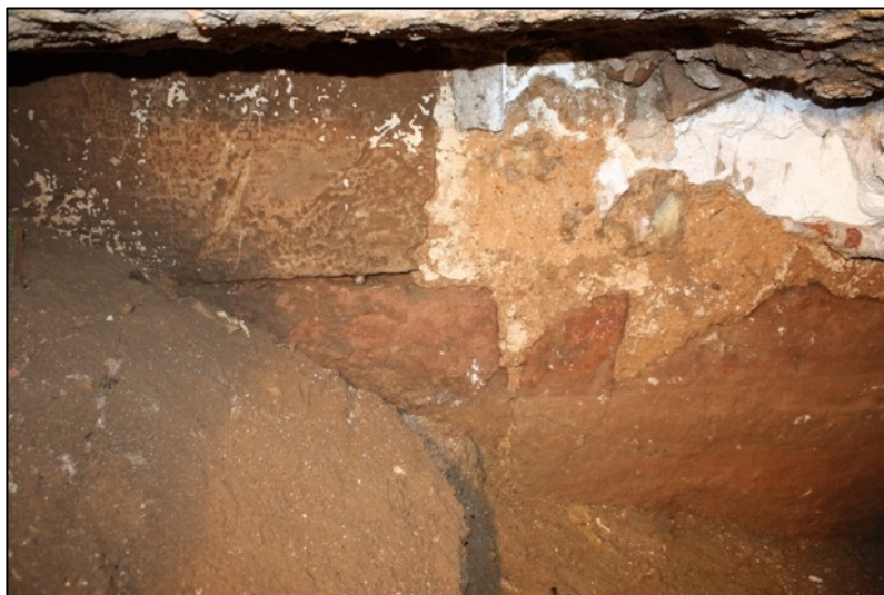
Fotografia 108. Detall arrebossat de morter de sorra UE1001 (s. XVI) en el parament de la torre 49.
