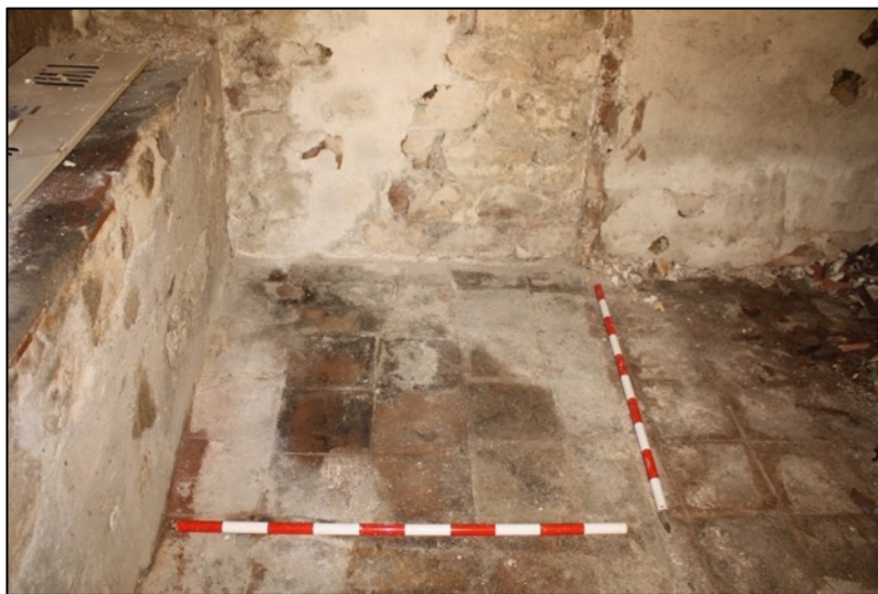
Fotografia 103. Paviment de rajoles de fang UE216.
