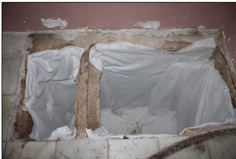
Fotografia 20. Cobriment de la cala K3 amb geotèxtil.
