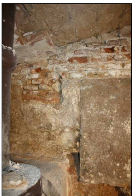
Fotografies 185 i 186. Detalls de diverses reparacions realitzades sobre el pany de la torre baix imperial a finals del segle XV-XVI, UE2013.
