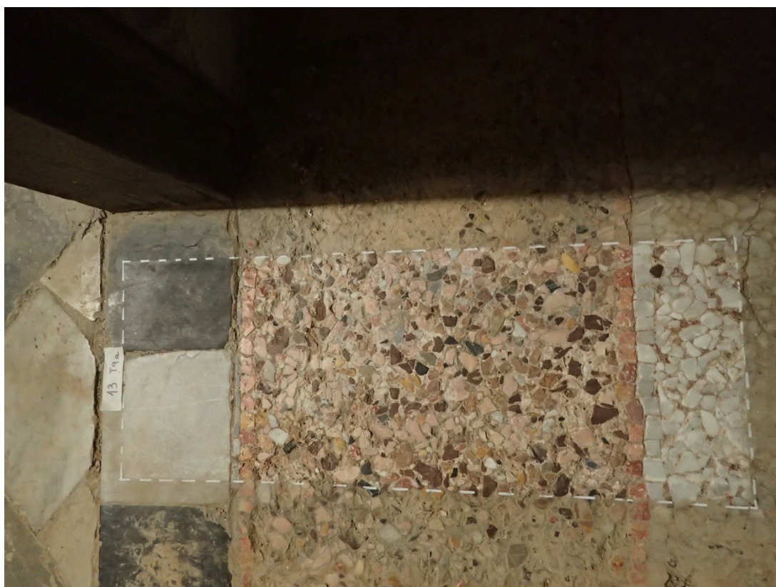
Paviments originals amb la tècnica del “terrazzo” italiano.
