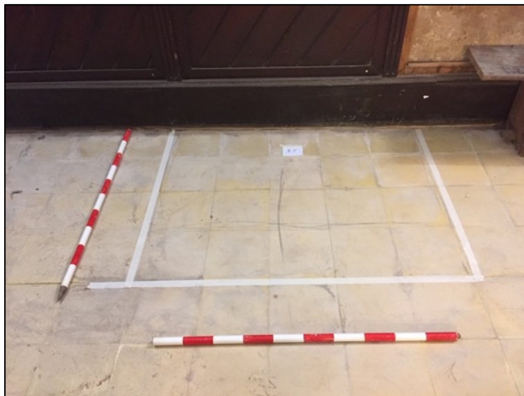
Fotografia 29. Paviment de rajoles hidràuliques UE140.
