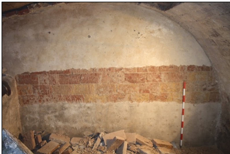
Fotografia 173. Aplacat de maons contemporani UE2005.
