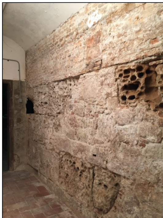
Fotografia 194. Reparacions pany de muralla s. XIX UE1005.
