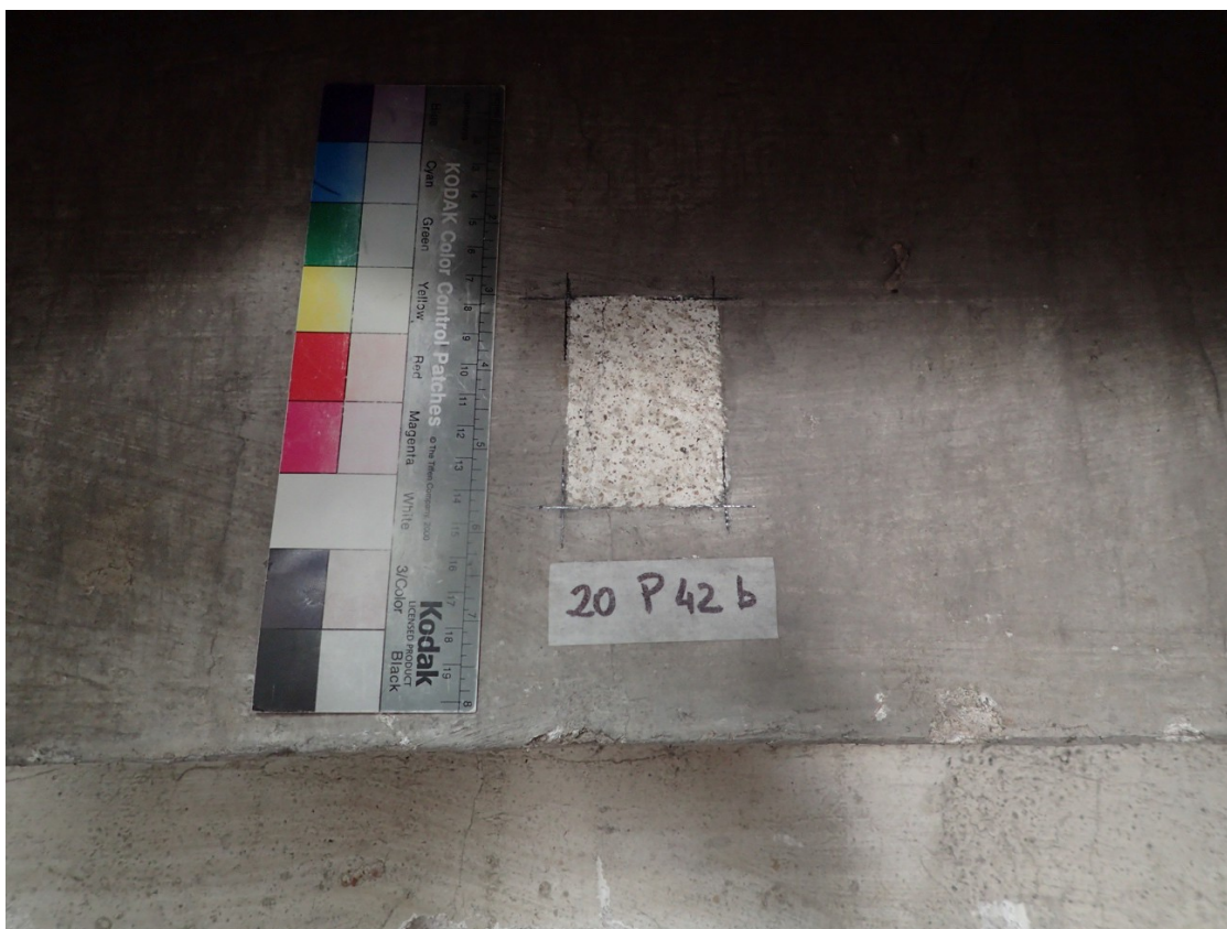
Estuc d'imitació granit trobat al recobriment d'una estructura de la coberta darrera d'una paret més moderna.
