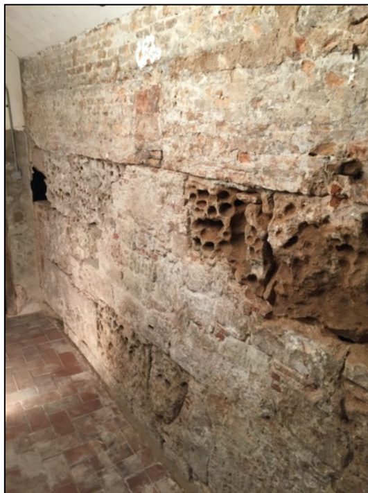
Fotografia 200. Frontal torre 49 amb mur de maons UE1010 aixecat en el moment de construcció del a finca veïna del carrer Palau 4 un cop enderrocat el Palau Reial Menor a mitjans del segle XIX.
