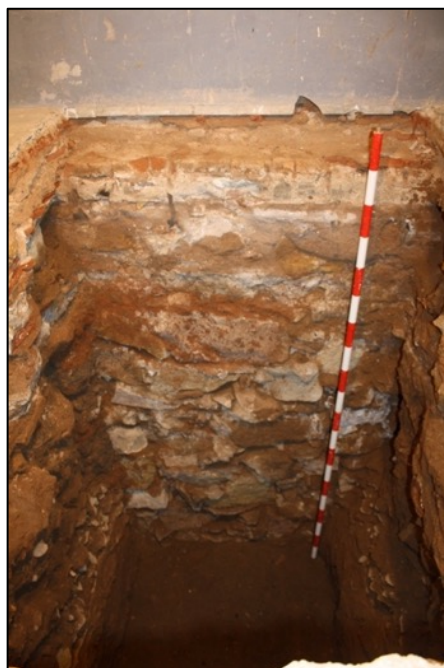
Fotografia 79. Vista del fonament UE259.
